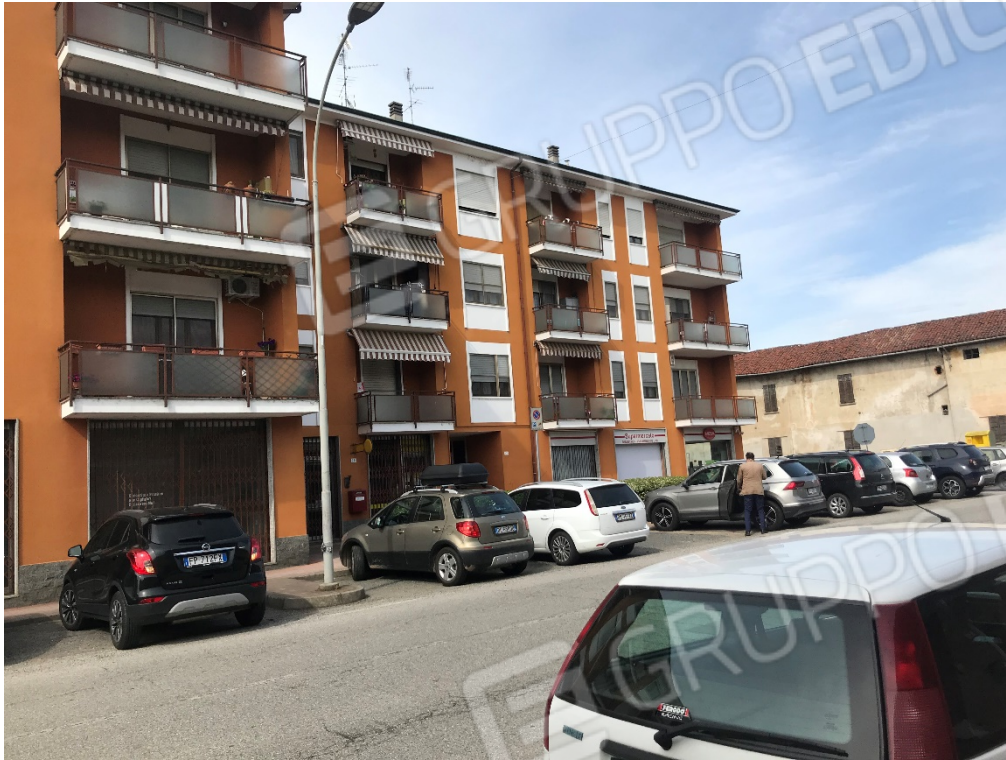
Foto n. 2: Prospetto principale su Via Umberto I
