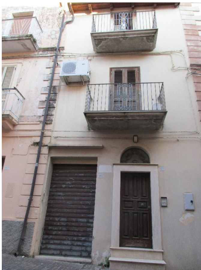
Foto n. 22 – Prospetto su via F. Fiorentino
