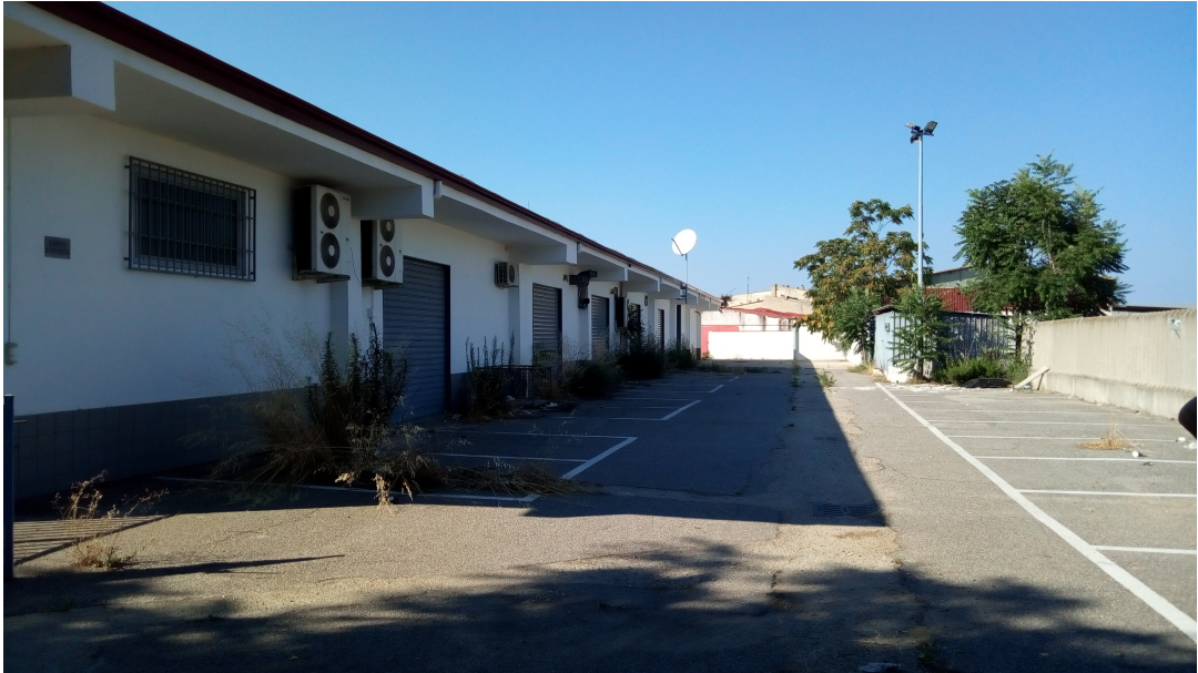
Vista dell'edificio e del piazzale retrostante
