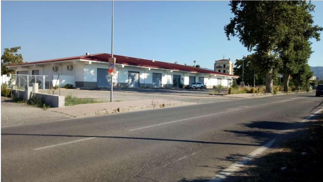
Vista dell'edificio e del piazzale dalla Strada Provinciale
