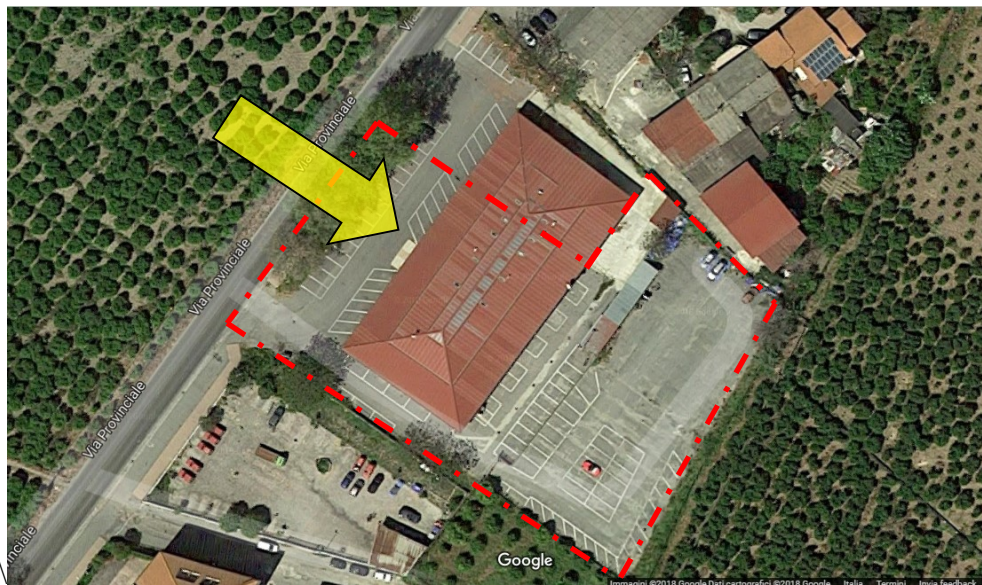
Viste aeree dell'edificio e dell'area in oggetto
