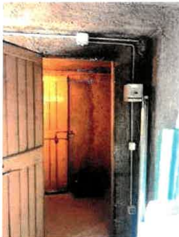
corridoio comune di accesso
