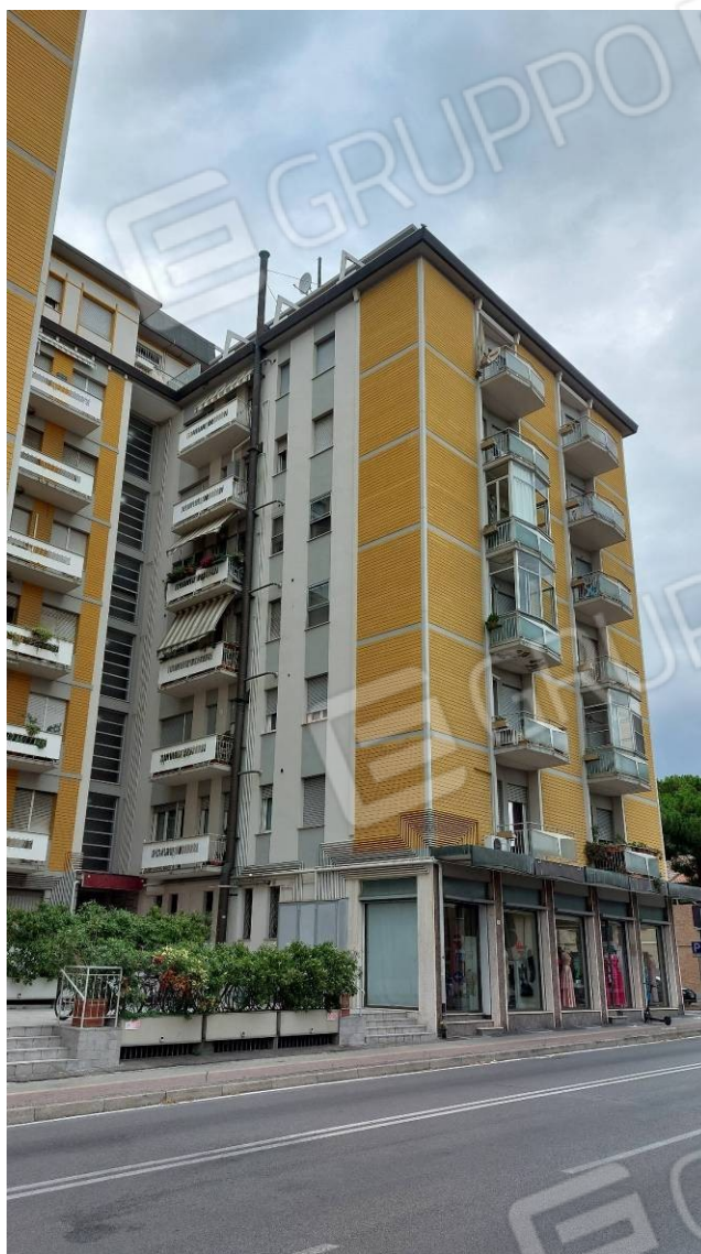
Vista da Via Rubicone (appartamento al terzo piano)
