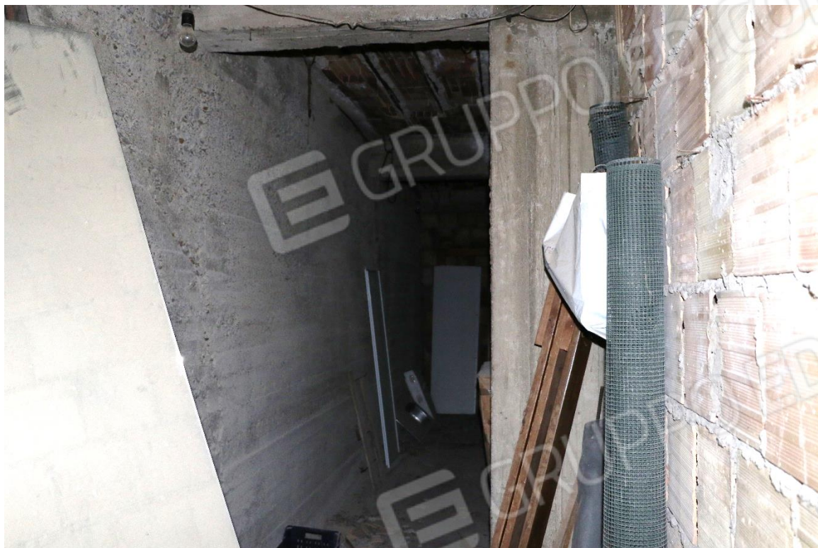
Foto 19 - Lotto 1 - Sub 3 - Deposito
