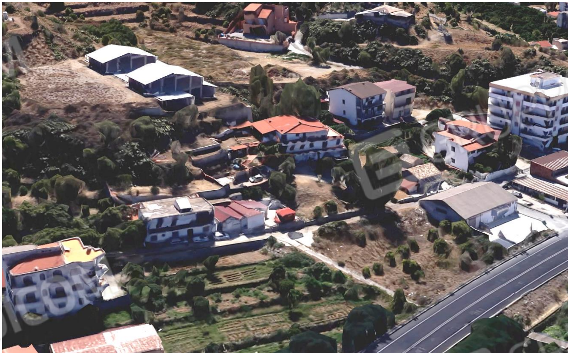
Foto 8 - Vista del tetto in tegole
