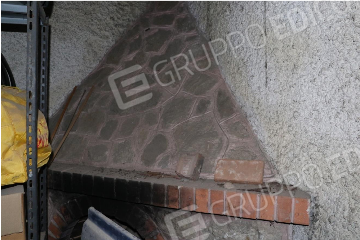
Foto 23 - Lotto 1 - Sub 3 - Deposito, particolare del camino
