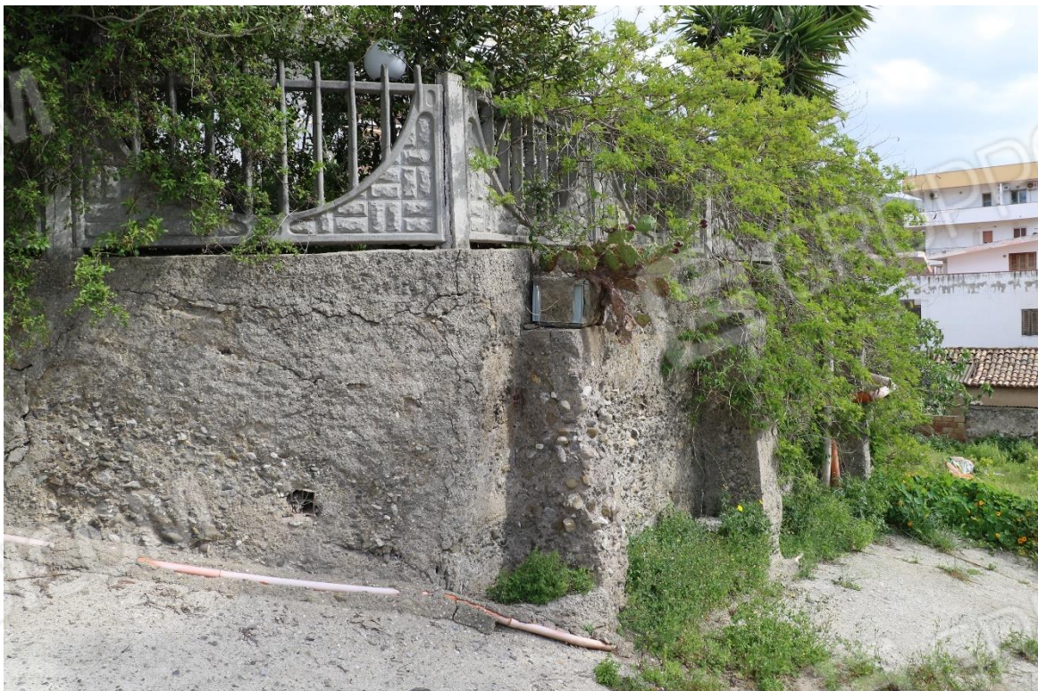
Foto 26 - Lotto 1 - Sub 12 - Illuminazione esterna
