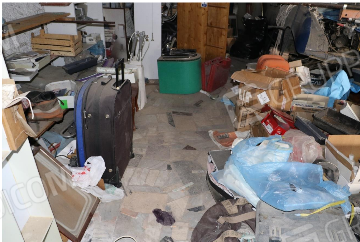
Foto 20 - Lotto 1 - Sub 3 - Particolare della pavimentazione del deposito
