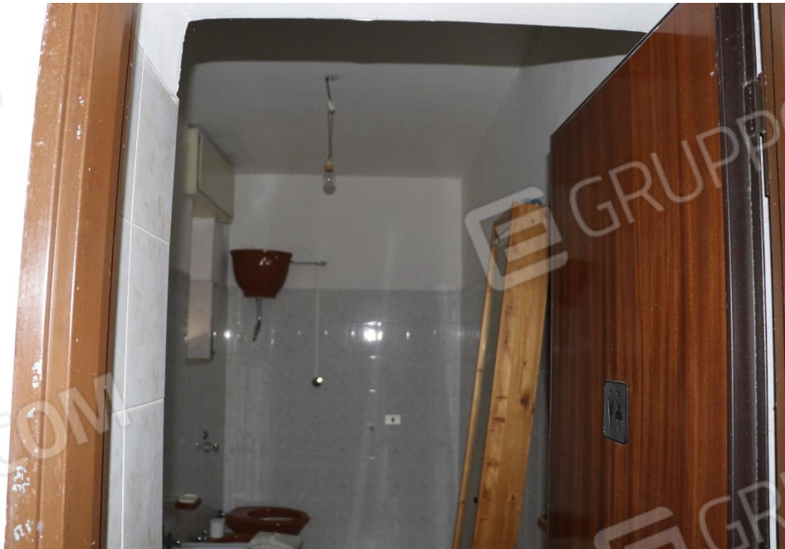
Foto 28 - Lotto 1 - Sub 13 - Illuminazione a soffitto
