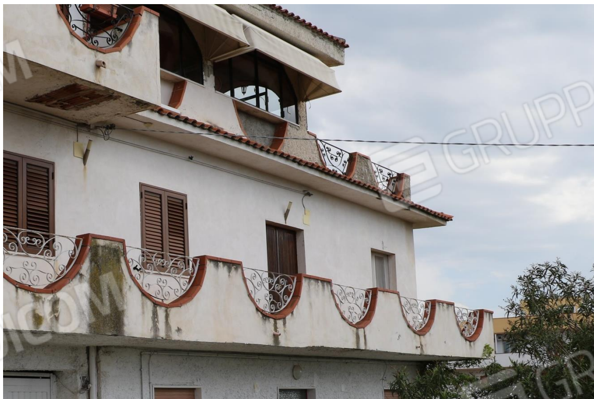
Foto 32 - Lotto 2 - Sub 15 - Ingresso
