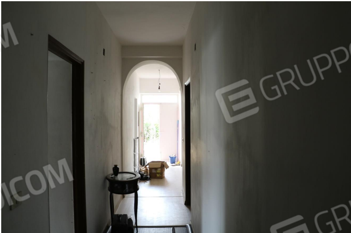
Foto 10 - Lotto 1 - Sub 13 - Corridoio
