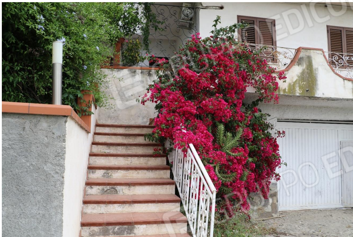
Foto 31 - La rampa di accesso all'altra unità immobiliare è stata separata tramite un muro divisorio
