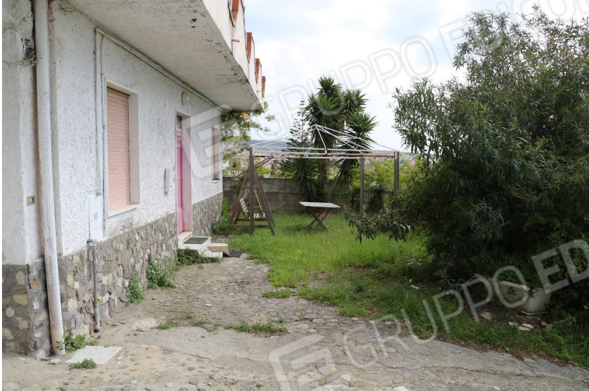
Foto 25 - Lotto 1 - Sub 12 - Pavimentazione della corte esterna
