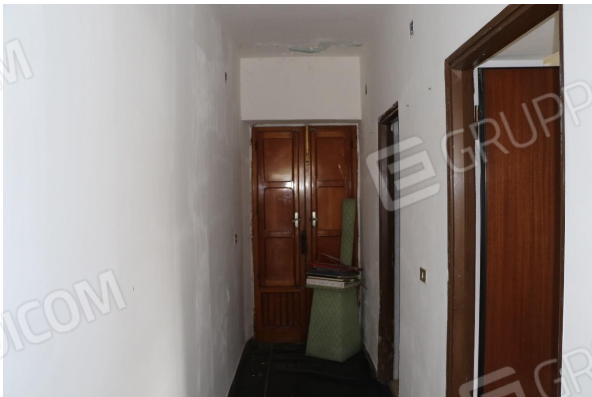
Foto 16 - Lotto 1 - Sub 13 - Corridoio
