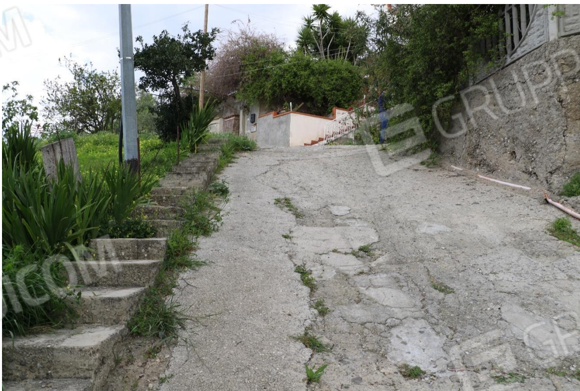
Foto 2 - Particolare della strada di accesso
