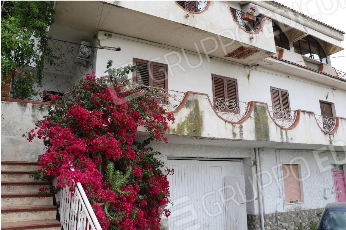
Foto 5 - Ballatoio di accesso al primo piano
