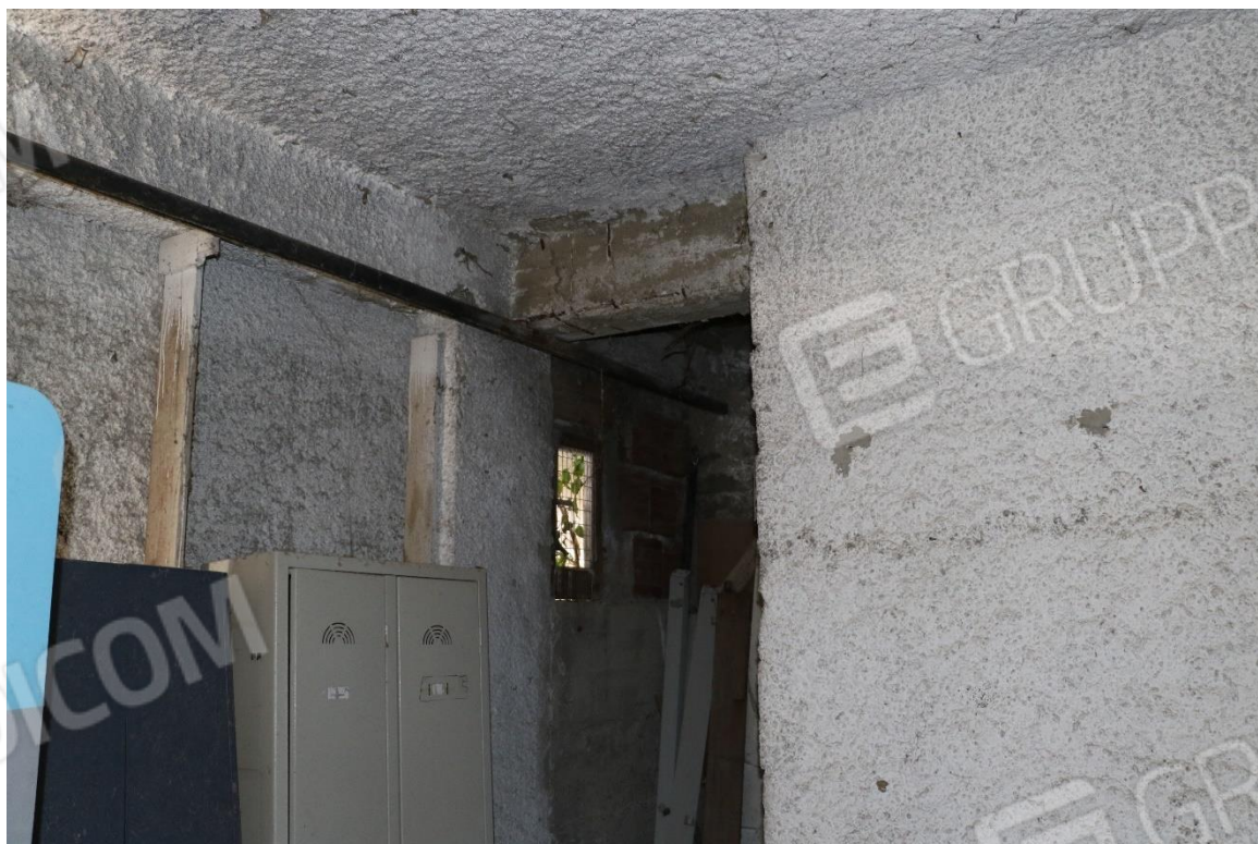
Foto 22 - Lotto 1 - Sub 3 - Particolare della finestra del deposito
