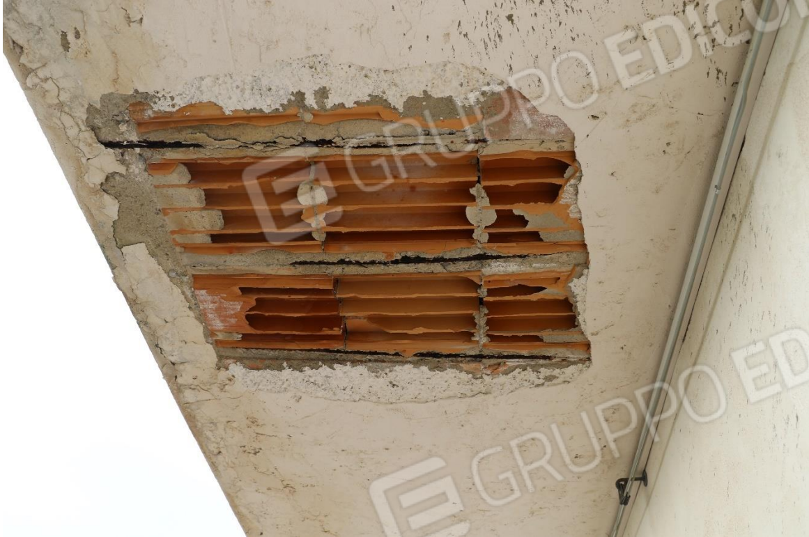
Foto 7 - Particolare del solaio in latero-cemento del balcone
