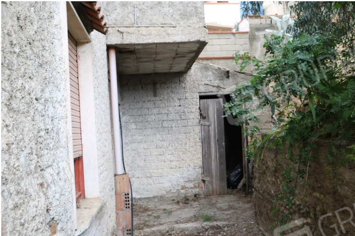
Foto 24 - Lotto 1 - Sub 14 - Ingresso magazzino sul retro
