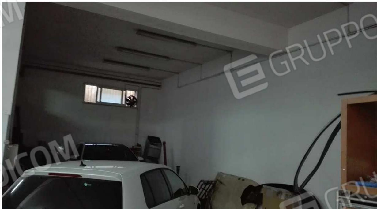
deposito annesso al laboratorio principale . La parete laterale, di separazione con l'unità confinante e sullo stesso piano, risulta realizzata in cartongesso
