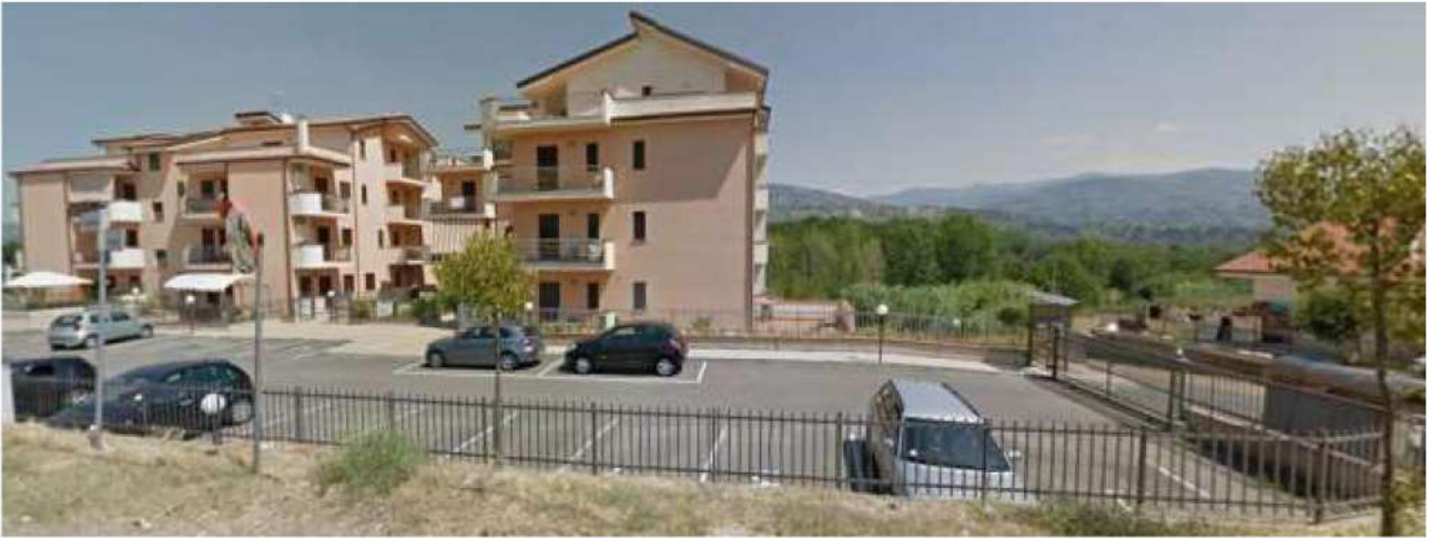
Fig. 4: Immagine prospetto lato ovest del complesso residenziale
