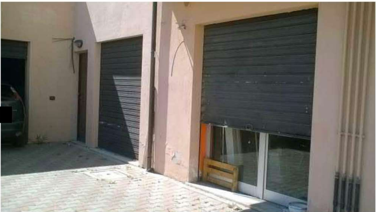
Fig. 8: Immagine area oggetto di perizia (Immobili accessibili dall'area in esame)
