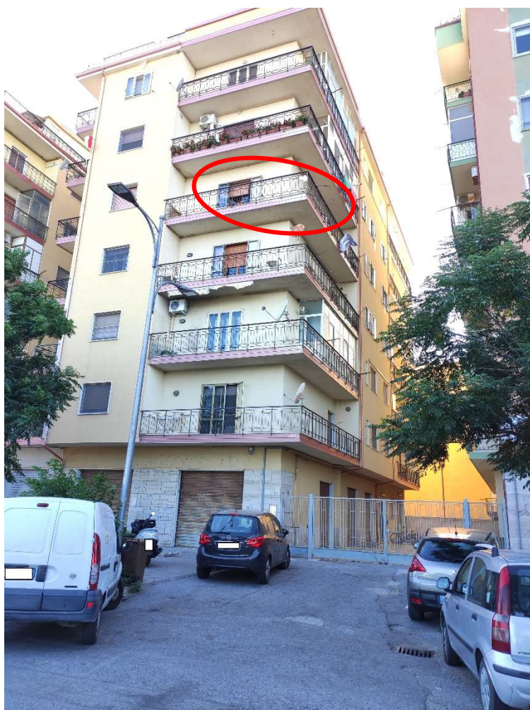
Foto n. 19: Vista edificio (cerchiato l'appartamento)
