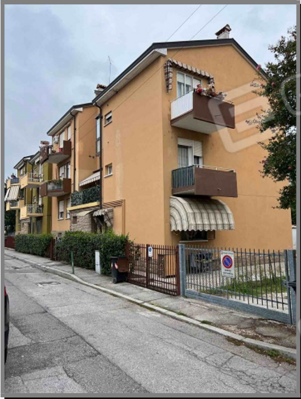
Vista EDIFICIO CIVICO 34
