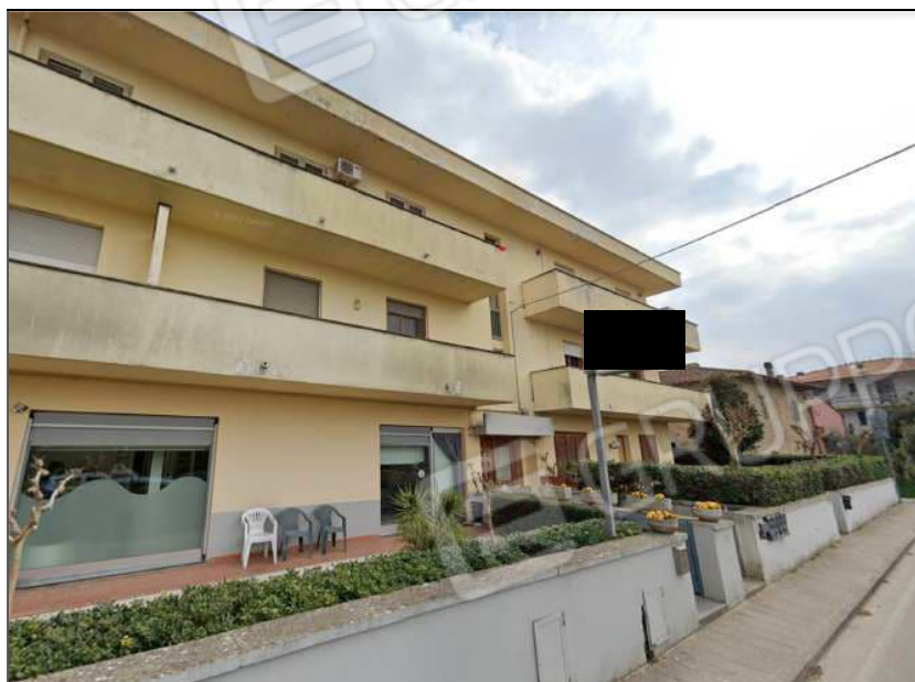
Foto 1 – Vista prospetto principale
