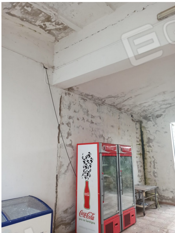
Foto 22 _ Vista interna deposito merci
