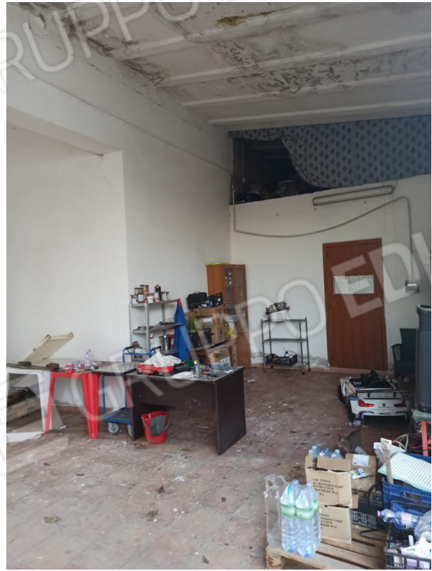
Foto 21 _ Vista interna deposito merci
