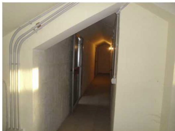
Corridoio di accesso alle soffitte
