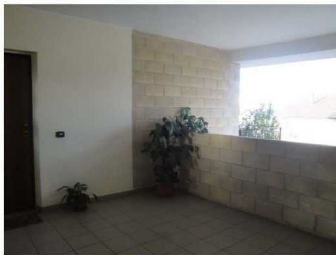
Pianerottolo aperto di accesso agli appartamenti
