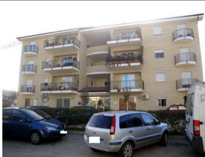
Esterno fabbricato lato Est – vista da via Cavour
