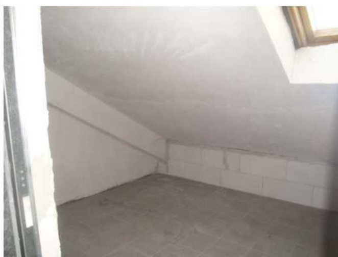
Immobile E – soffitta sub 21
