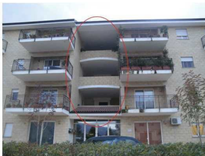
Pianerottoli aperti di accesso agli appartamenti
