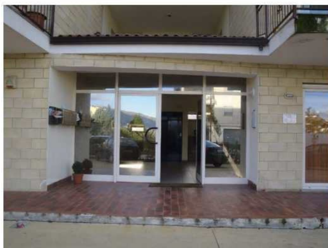
Portone di accesso sul prospetto Est
