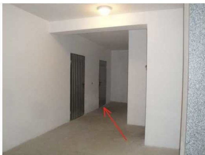
Ingresso cantinola da vano scala piano interrato
