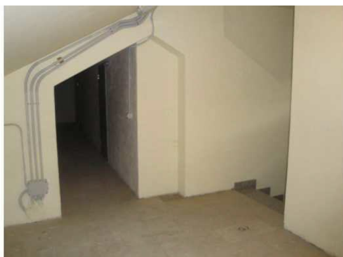
Vano scale soffitte
