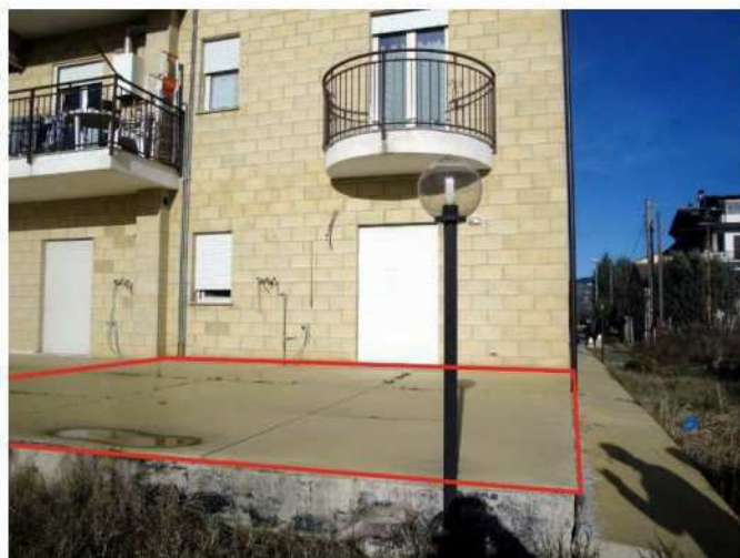
Corte esterna pertinenziale lato ovest
