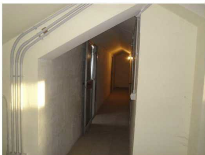
Corridoio accesso soffitte posto a sud del vano scala
