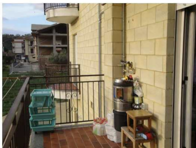
Balconi cucina e camera nord-ovest
