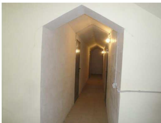
Corridoio accesso soffitte posto a nord del vano scala
