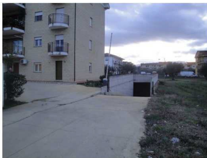
Rampa di accesso interrato – vista da via Cavour
