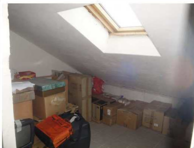
Immobile G – soffitta sub 23
