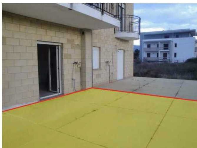
Corte esterna pertinenziale lato ovest
