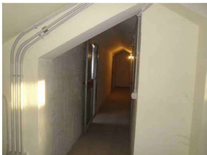
Corridoio di accesso alle soffitte
