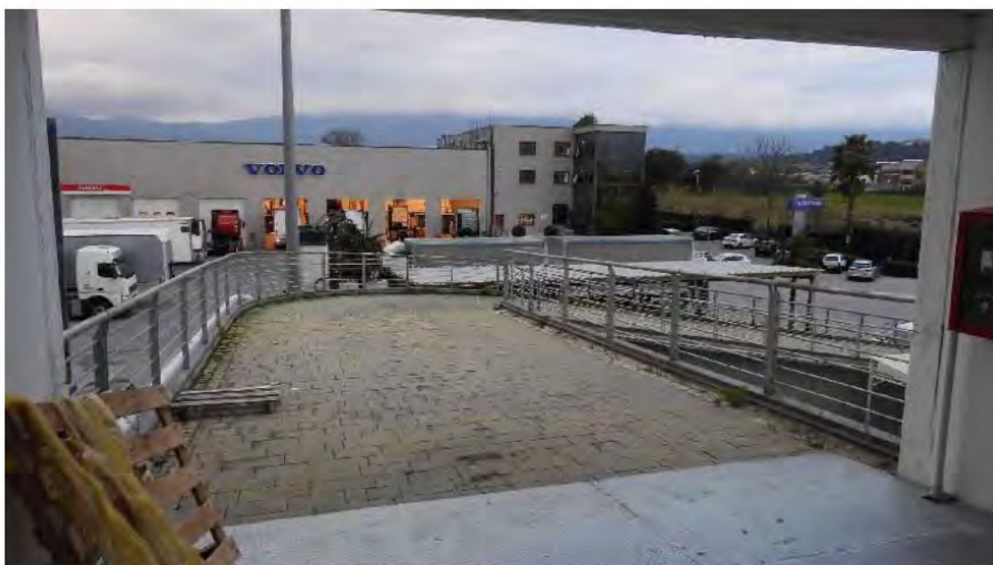
Foto 7: Rampa di accesso
