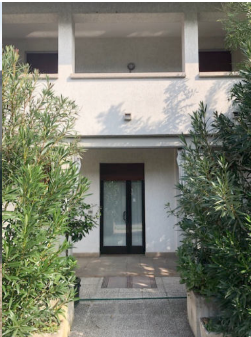
foto 8 accesso piano terra abitazione
