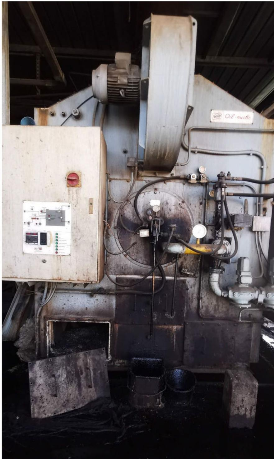
Foto 3: Centrale termica a olio diatermico - OIL MATIC
