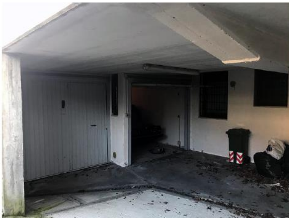
Villa Flora Sub19 (aperto) e 20 (chiuso) – I garage al piano interrato.
