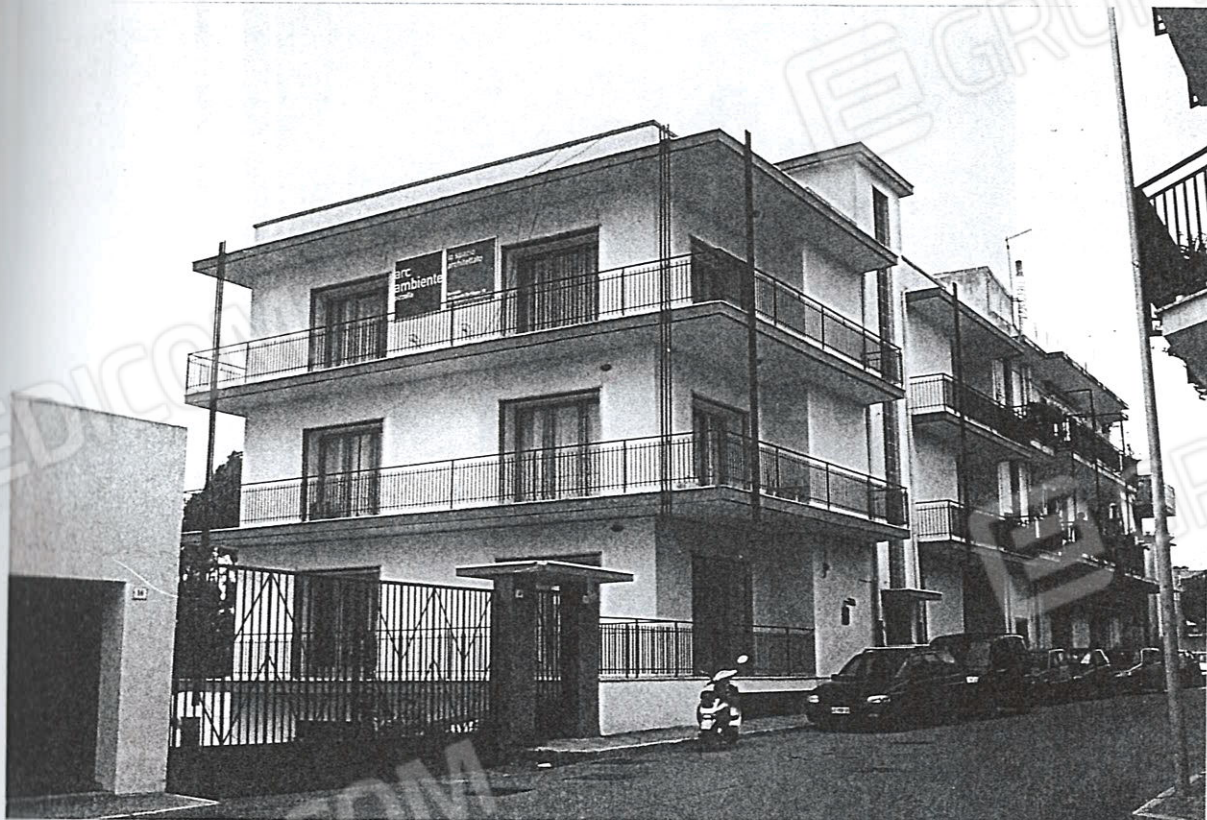
foto 2 – Bernalda, fabbricato in via De Filippo n° 10, f. 31, ptc. 3385, sub. 2 – prospetto laterale
