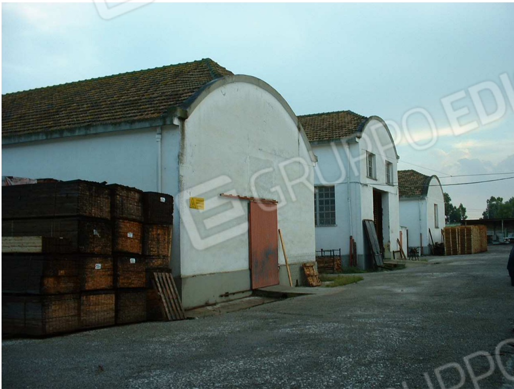
foto 5 – Contrada Mercuragno – foto d'archivio capannoni - f. 43 ptc. 179 -180 -181 fronte ovest
