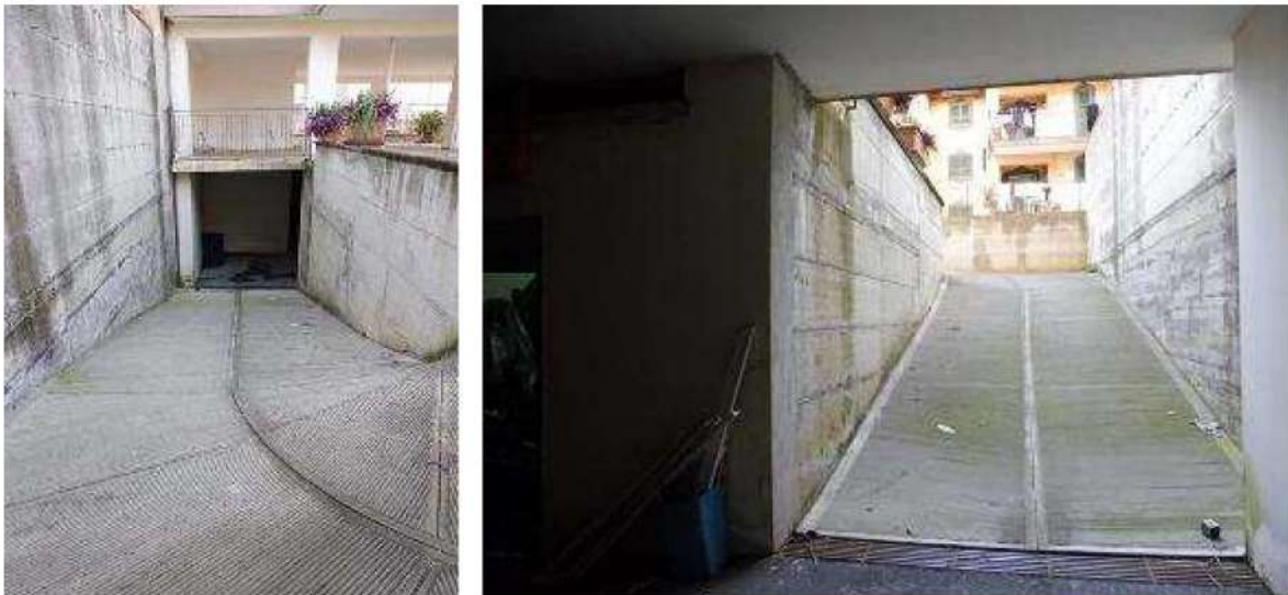
_rampa di accesso al piano seminterrato
