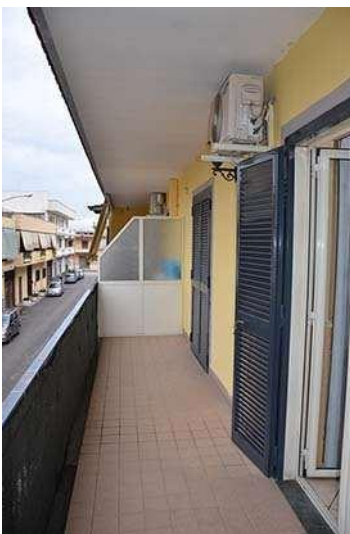
_balcone SU Strada
