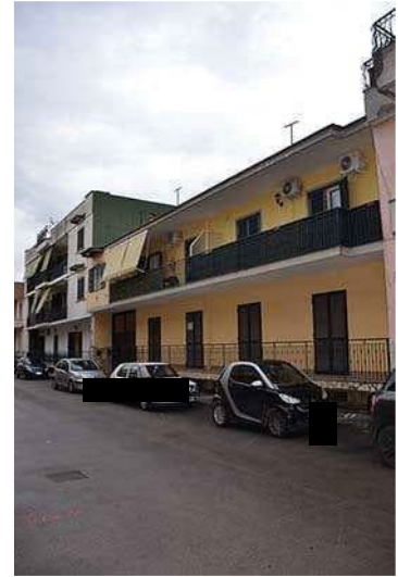
_viSte del fabbricato dalla Strada
