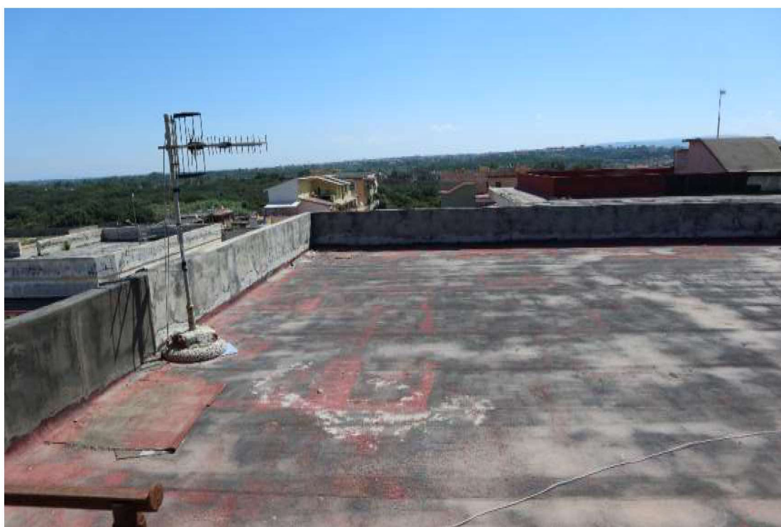
VISTA LATO ENTROTERRA
