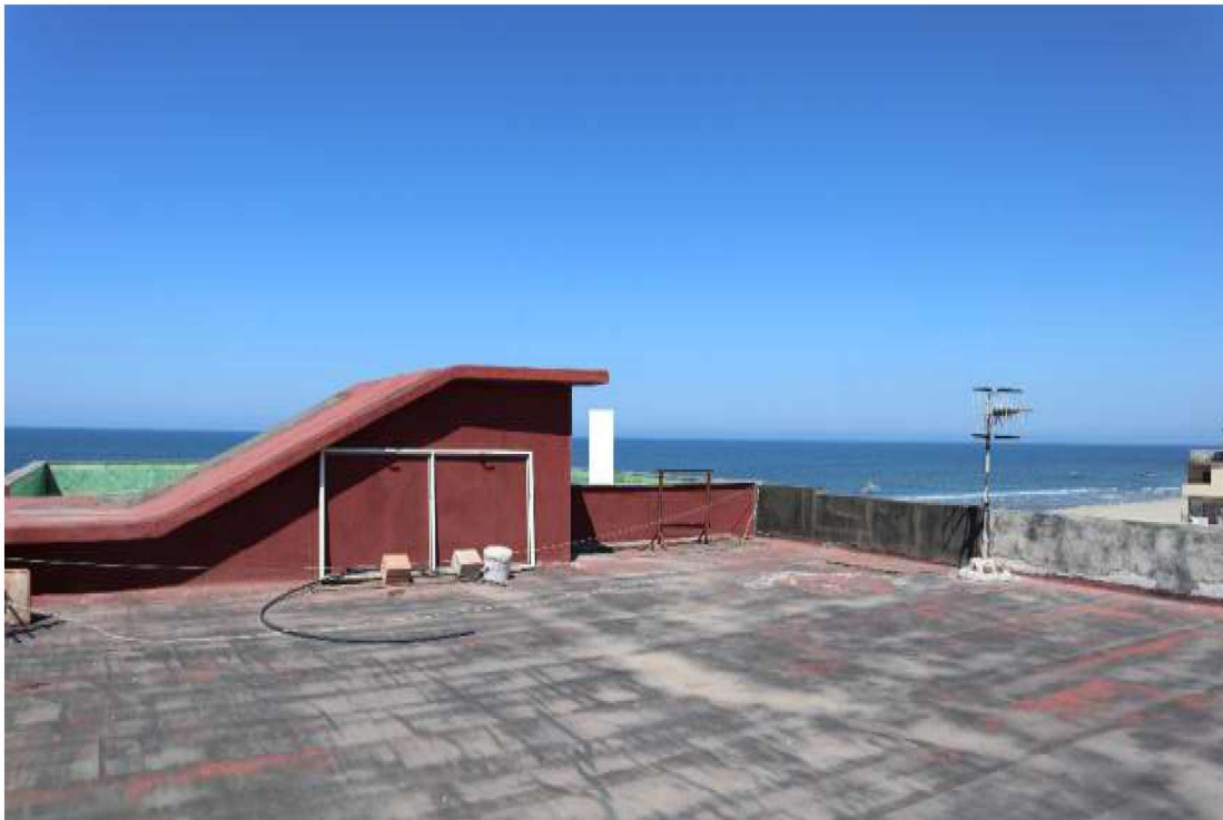
Viste del lastrico solare
