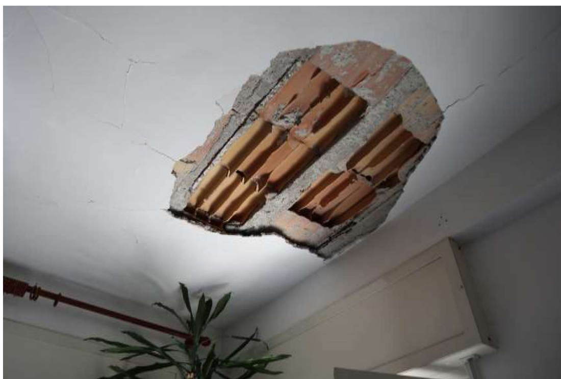
VISTA DEL DISTACCO ALL'INTRADOSSO DELLA CAMERA A SUD
