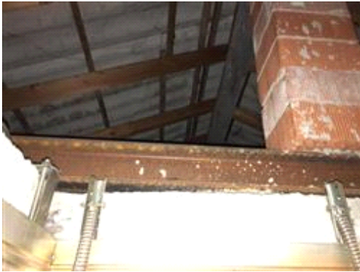
veduta manto di copertura in lastre di fibro-cemento (eternit)
