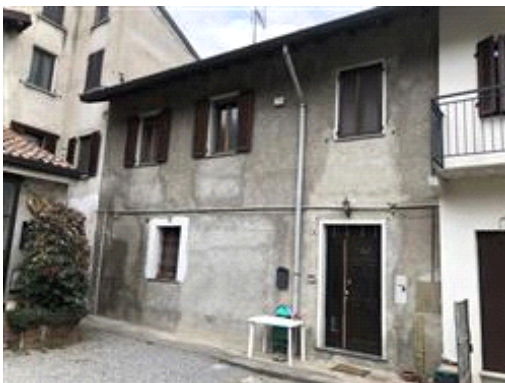
prospetto verso cortile comune
