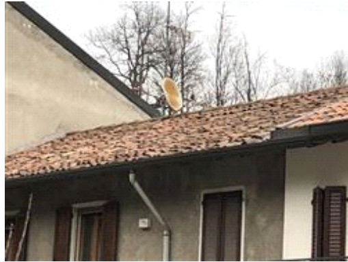
veduta secondo manto di copertura in coppi
