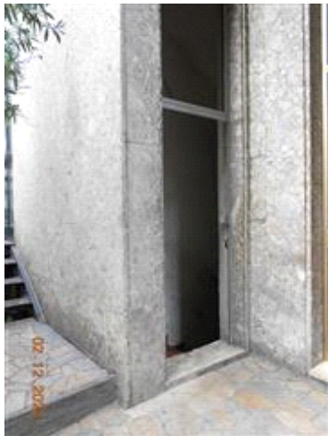
PORTA DI ACCESSO AL PIANO S1
