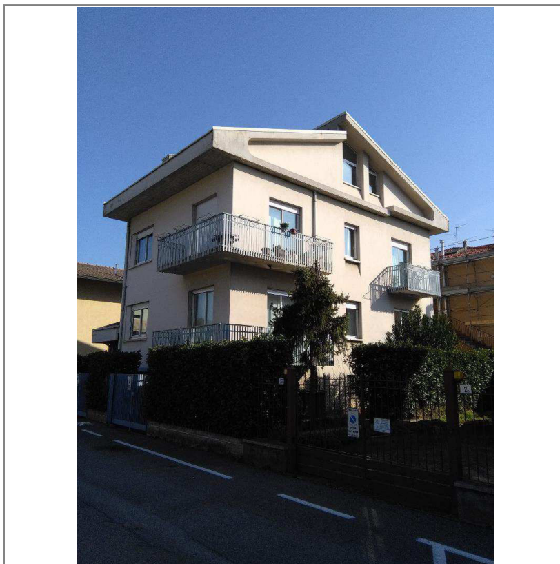
- Palazzina di civile abitazione - Fronti ovest e sud -
