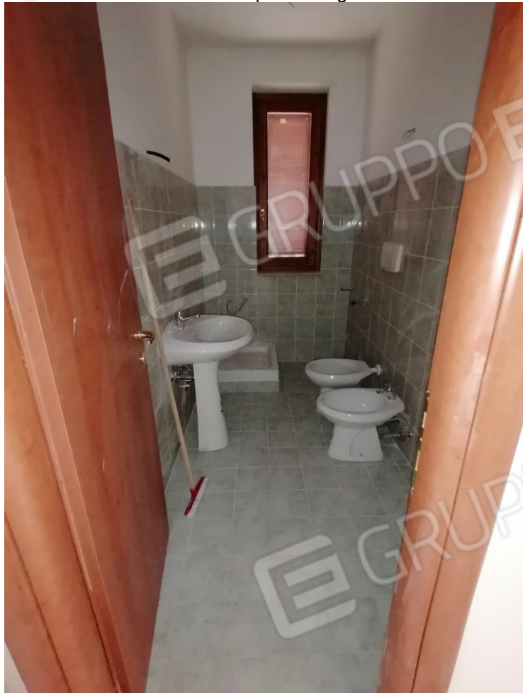
FOTO N°09: Corpo A – Bagno – P2.
