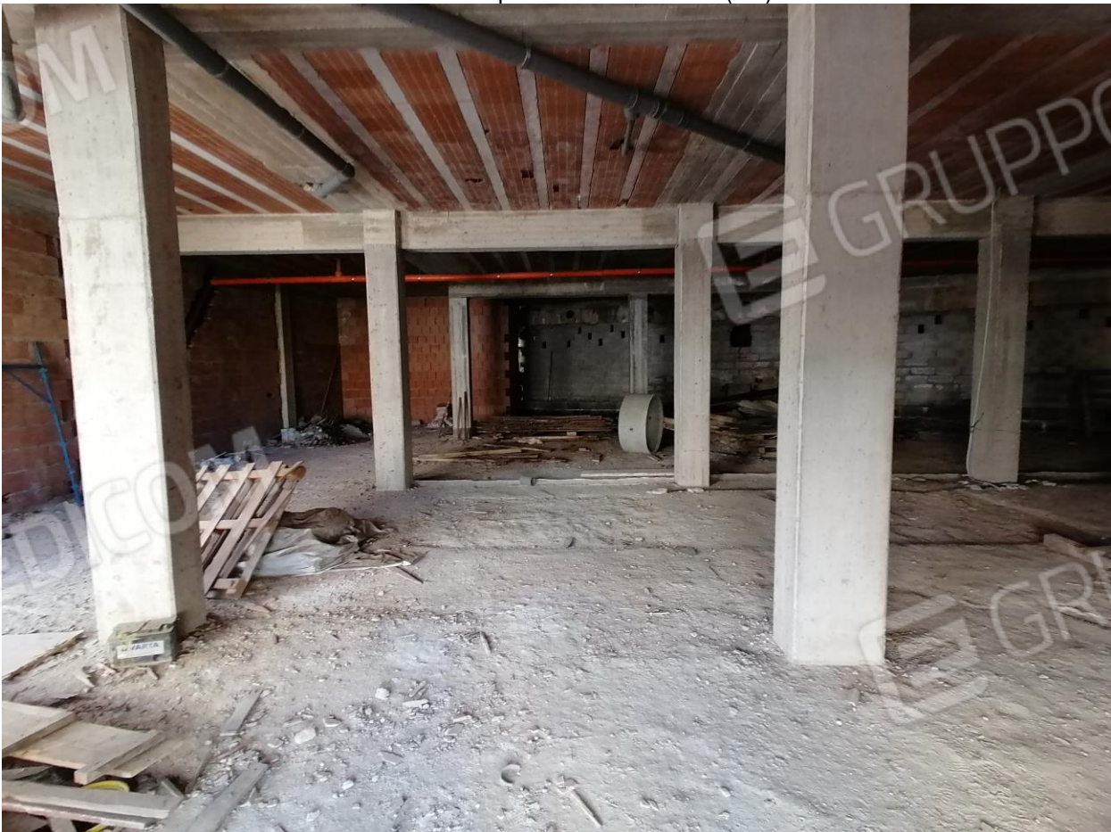
FOTO N°41: Corpo H – Locale 1 – PT (1/2).
