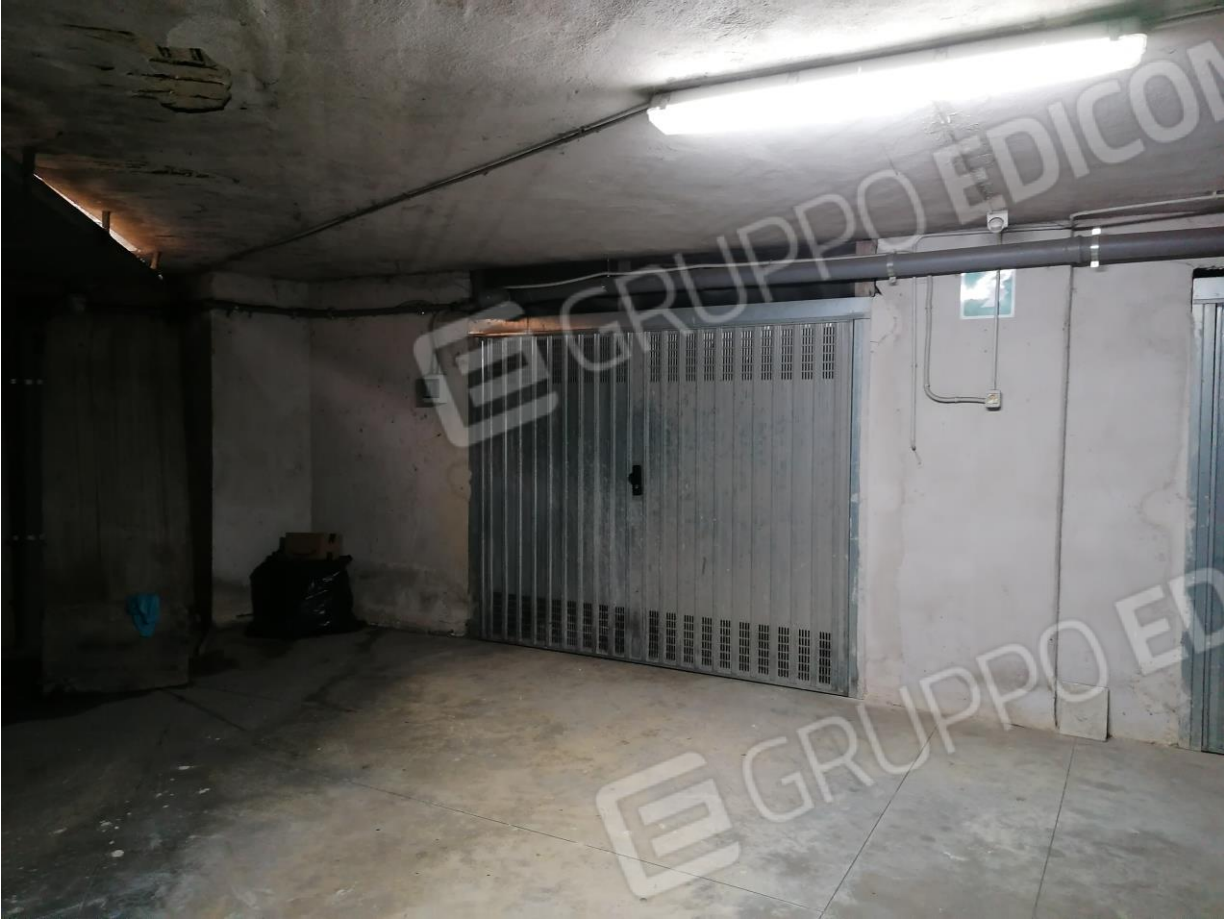
FOTO N°35: Accesso al Corpo F – Piano Sottostrada.
