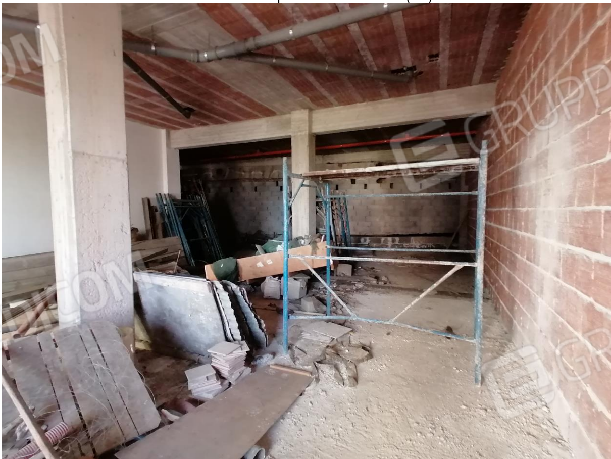
FOTO N°45: Corpo H – Locale 2 – PT (1/2).
