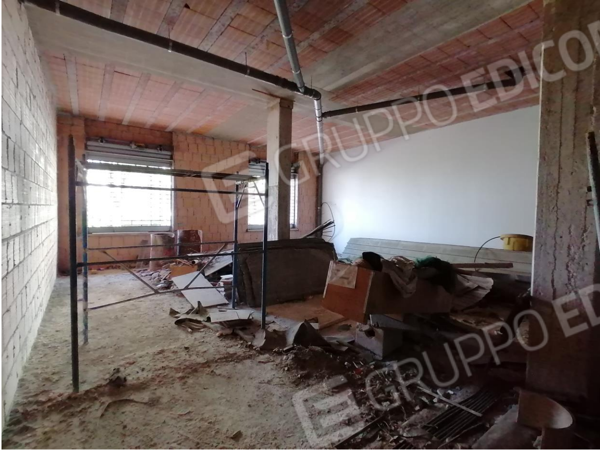
FOTO N°44: Corpo H – Locale 2 – PT (1/2).
