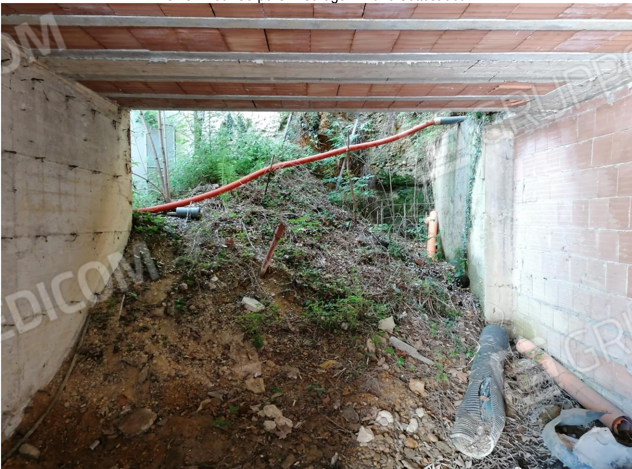
FOTO N°39: Corpo G – Garage – Piano Sottostrada.
