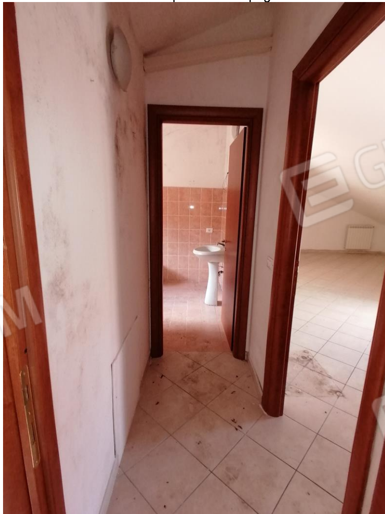
FOTO N°25: Corpo C – Disimpegno – P3.
