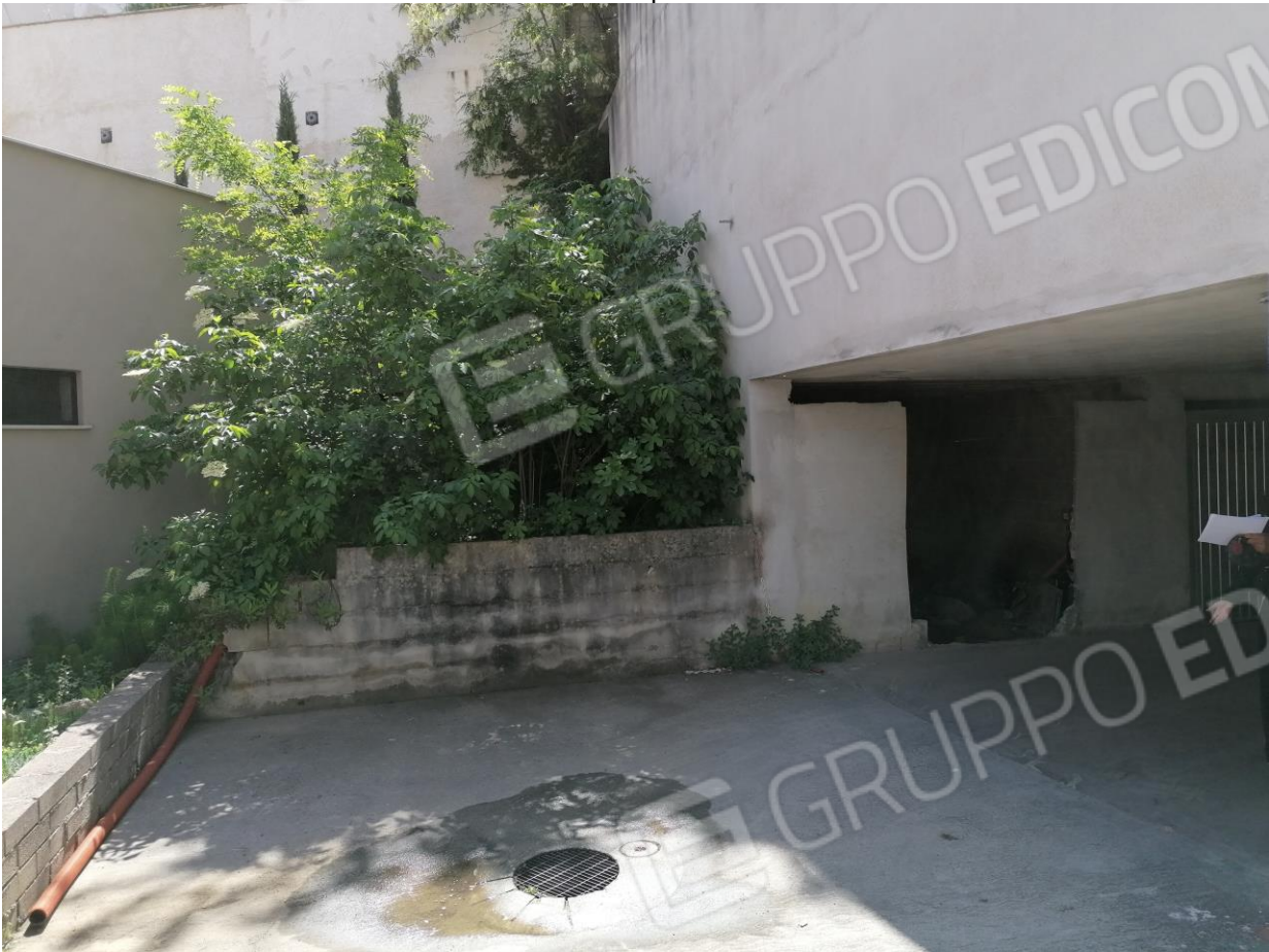
FOTO N°38: Accesso al Corpo G – Piano Sottostrada.
