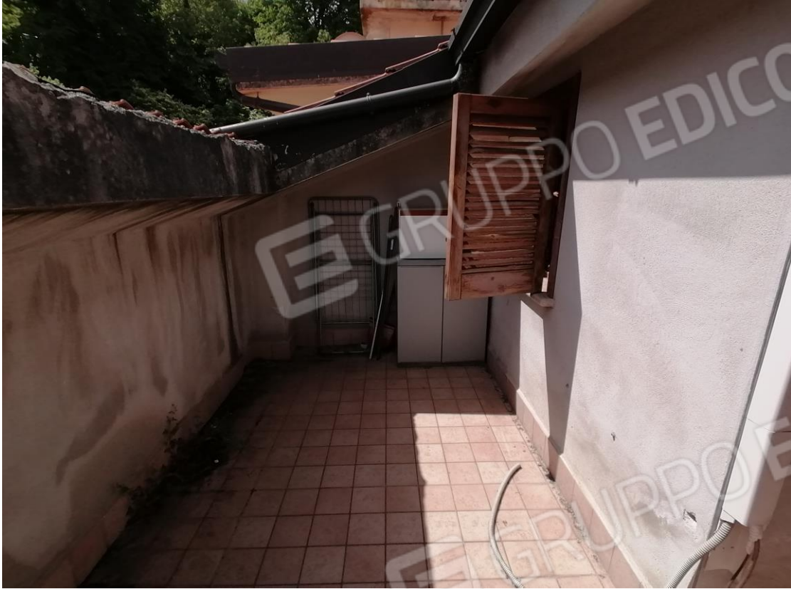
FOTO N°28: Corpo C – Balcone esposto a sud-est- P3.
