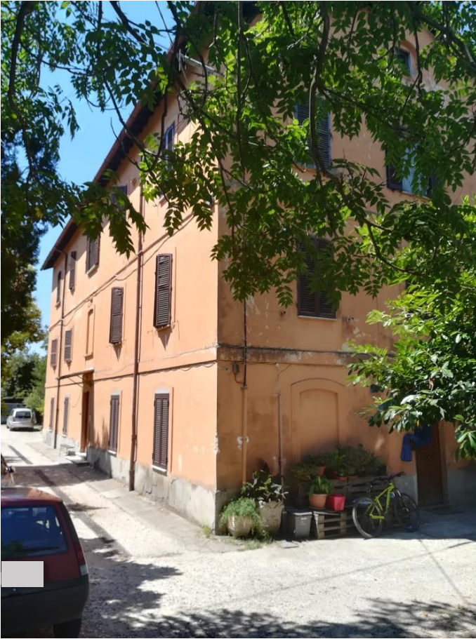
Foto 6 – Vista del fabbricato, lato nord
