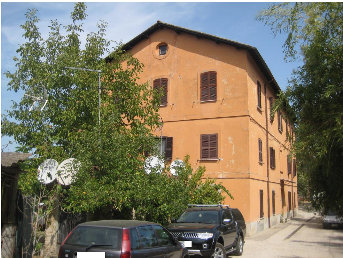
Foto 5 – Vista del fabbricato, lato sud
