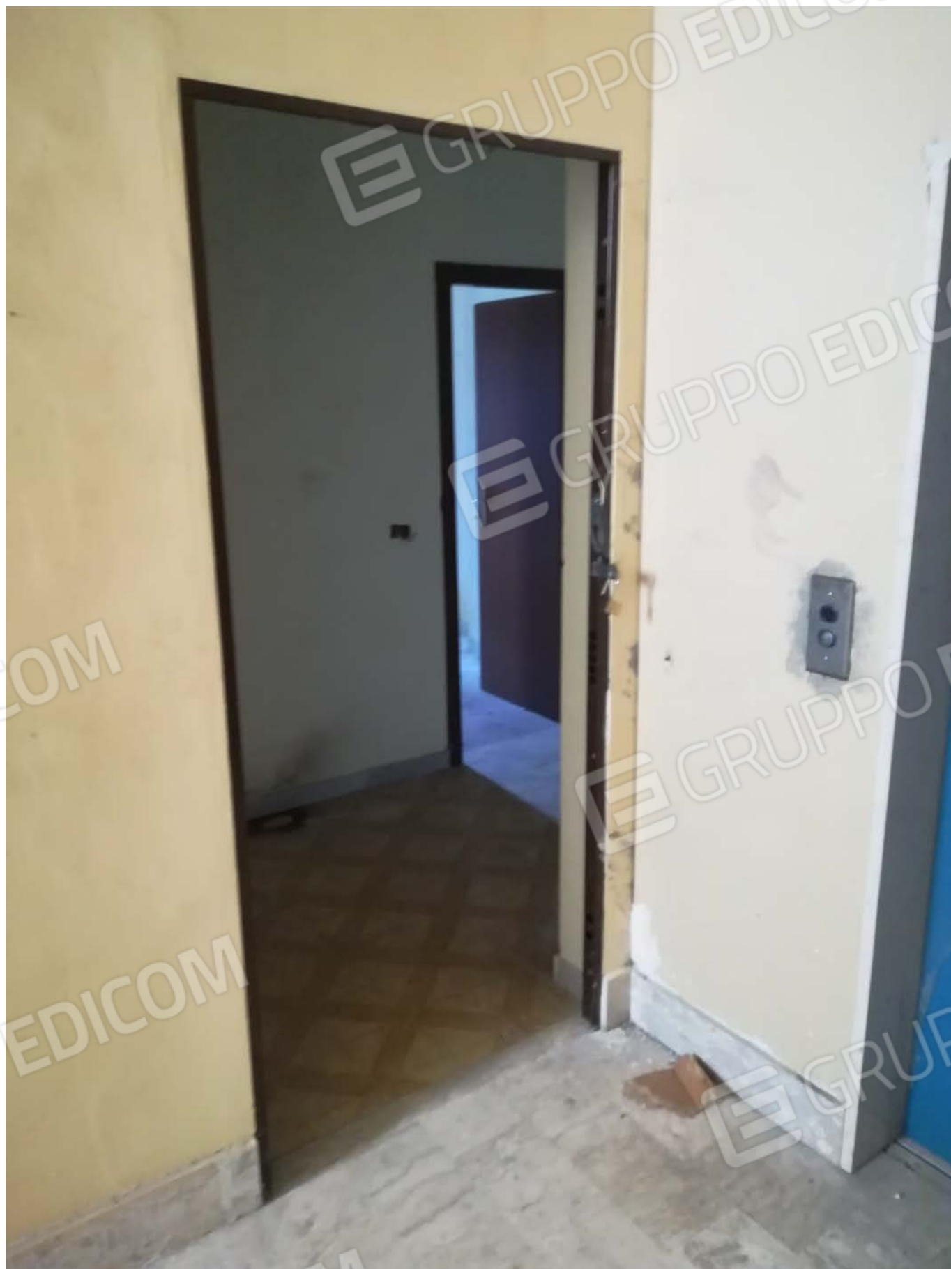
Foto 100 – Scala D piano 6° interno 12
