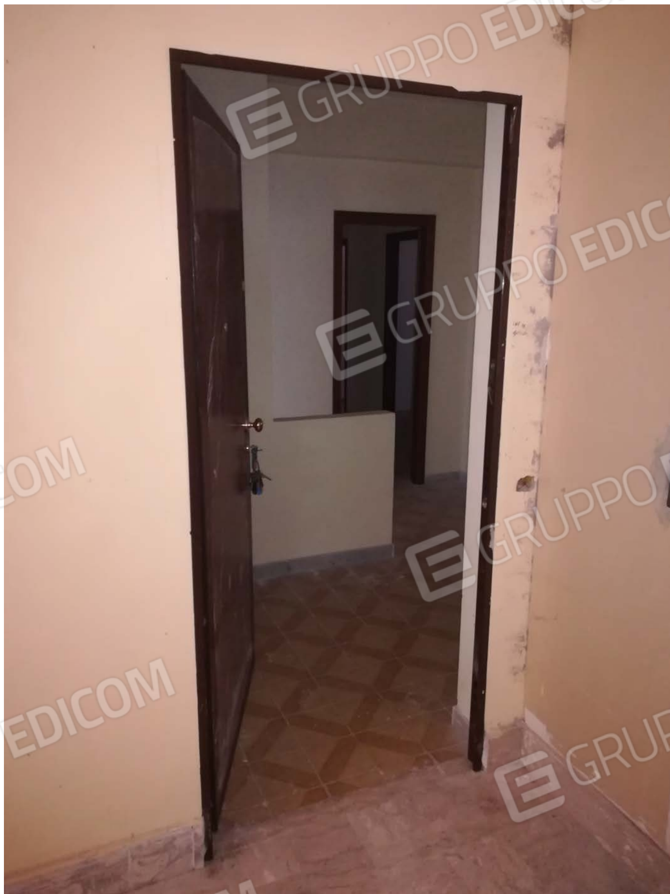
Foto 90 – Scala D piano 5° interno 10
