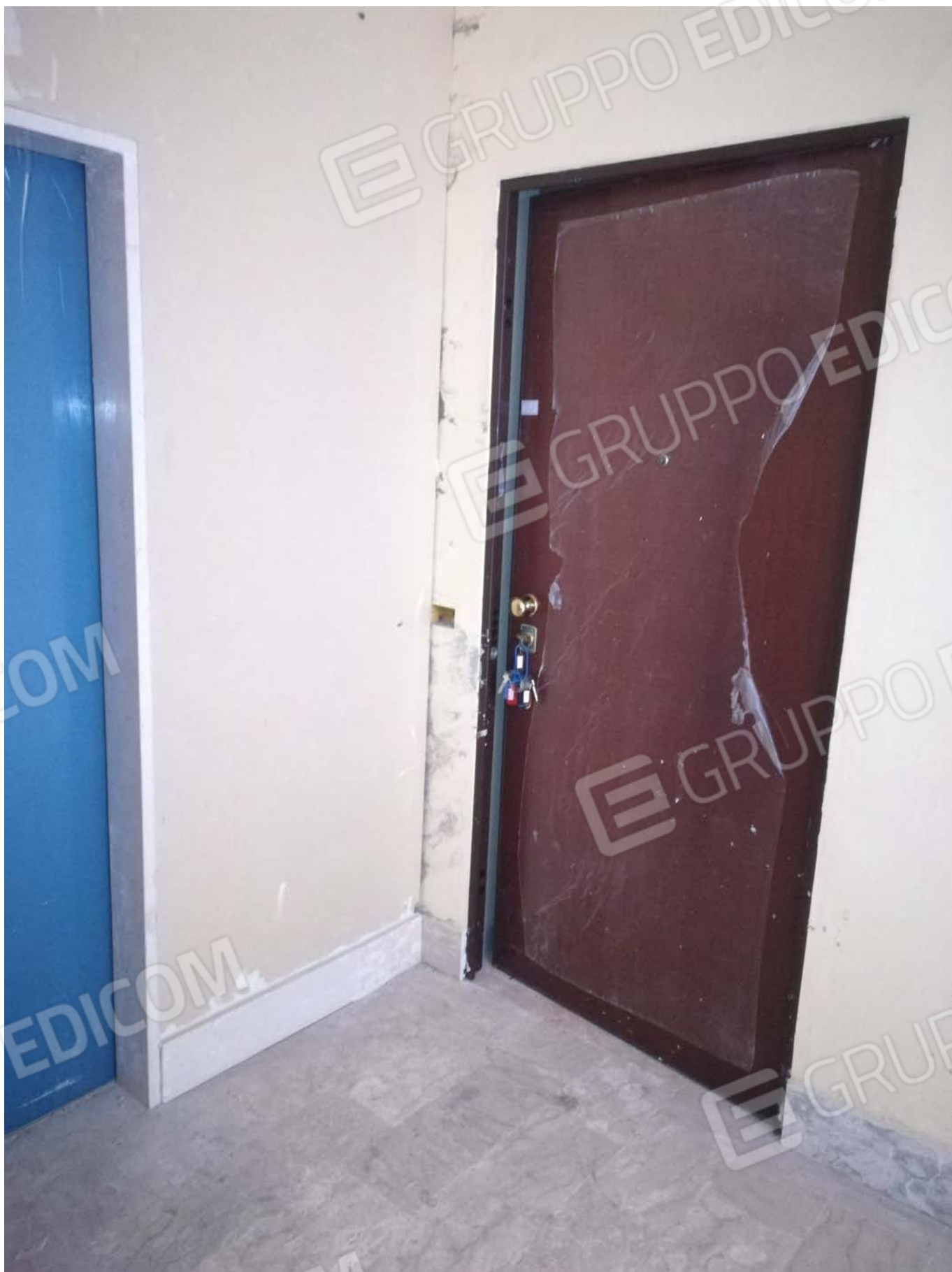
Foto 63 – Scala D piano 4° interno 7
