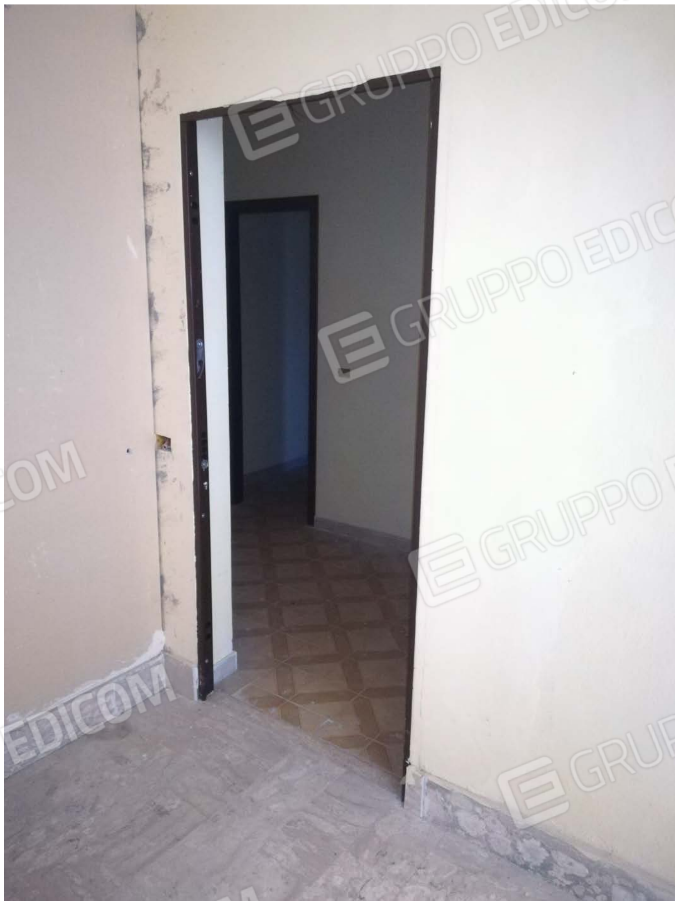
Foto 81 – Scala D piano 5° interno 9
