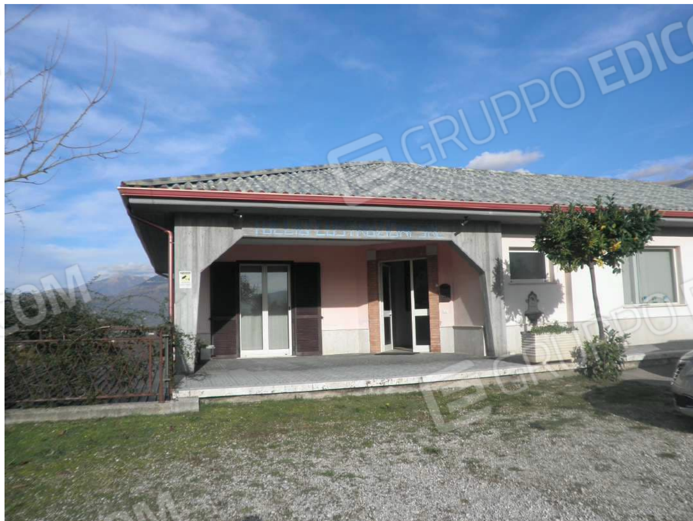
FABBRICATO USO UFFICIO fg 2 p.Ila 106
