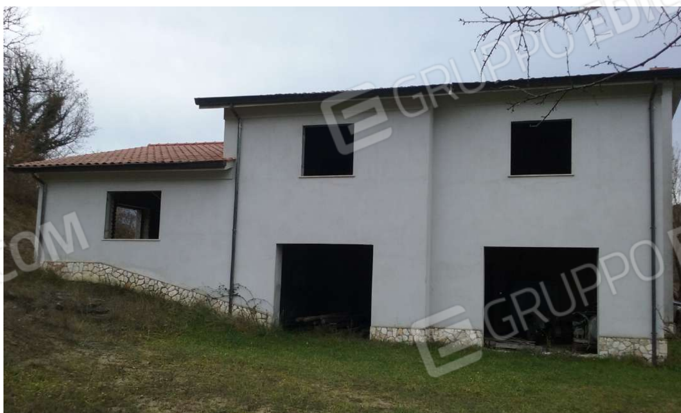
FABBRICATO IN CORSO DI COSTRUZIONE fg 14 p.lla 738
