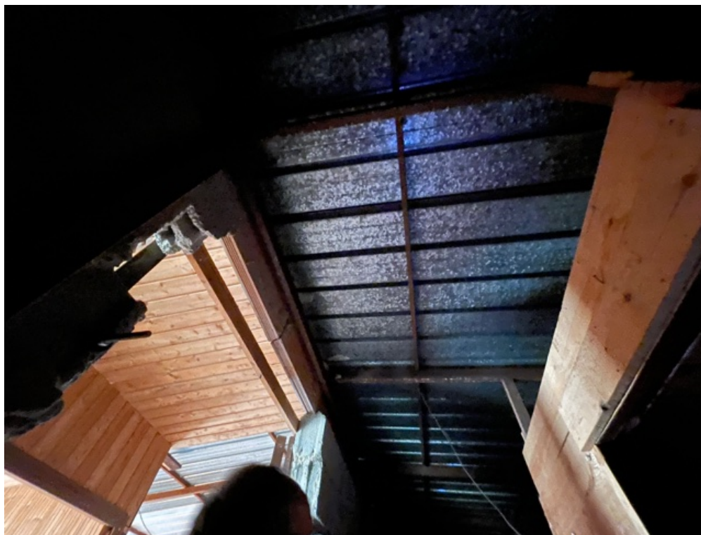
foto 4_ vista copertura sottotetto
