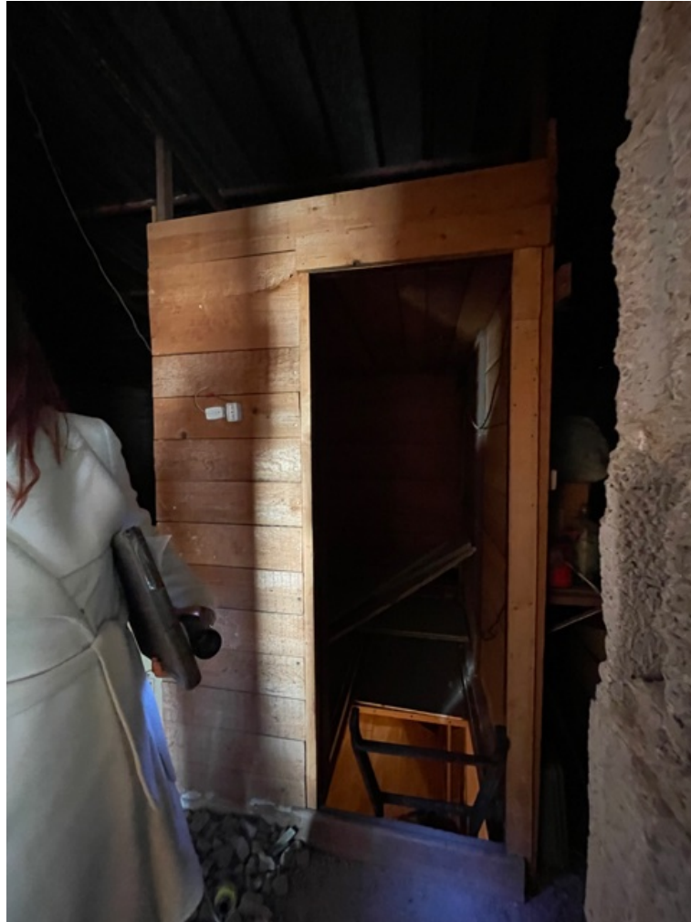
foto 3_ vista dal sottotetto della botola di accesso
