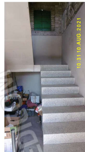
SCALA INTERNA COLLEGAMENTO PIANO PRIMO E SECONDO
