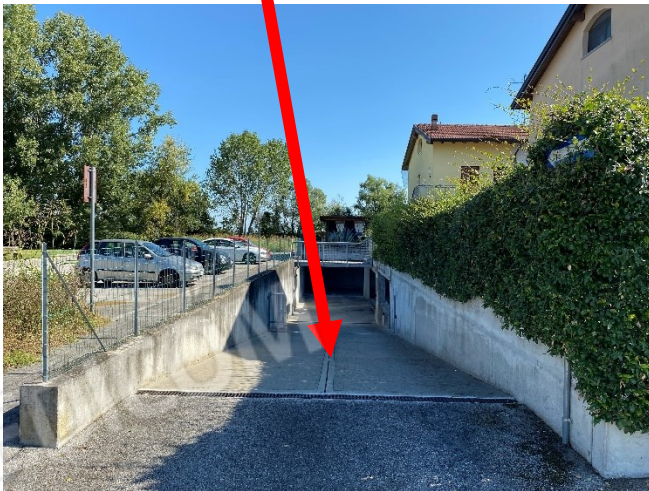
prospetto visto dalla strada della rampa delle autorimesse e posti auto coperti
