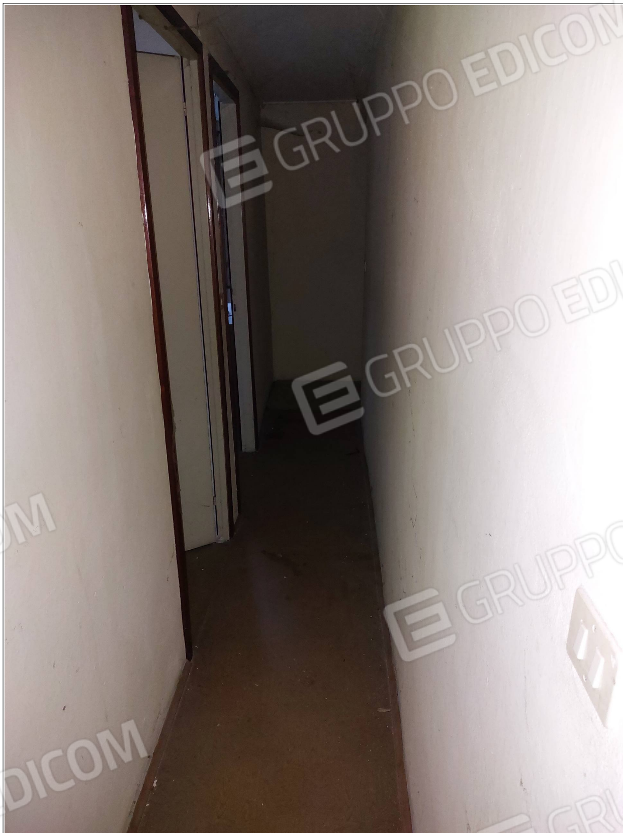
Foto n° 14 - Comune di Annone Veneto, foglio 1, part.1032 – Piano primo. Corridoio.
