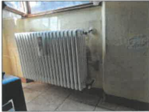
FOTO 52 - RADIATORE IN ACCIAIO
