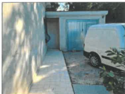
FOTO 13 - FRONTE LATERALE E VISTA DELL'AUTORIMESSA
