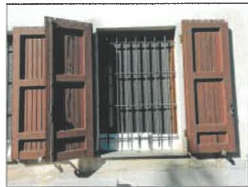
FOTO 27 - DETTAGLIO FINESTRA SUL FRONTE RETROSTANTE
