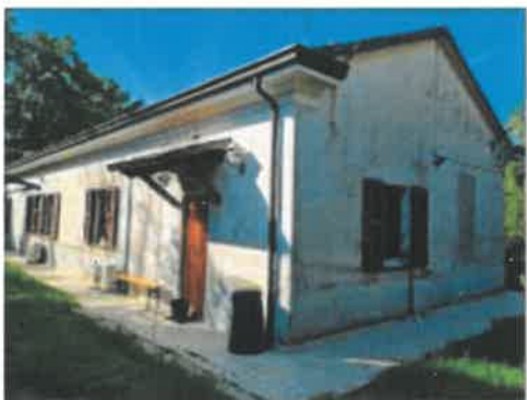
FOTO 07 - FRONTE RETROSTANTE E FRONTE LATERALE
