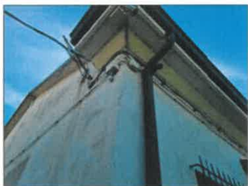
FOTO 22 - CORNICIONE E GRONDAIA
