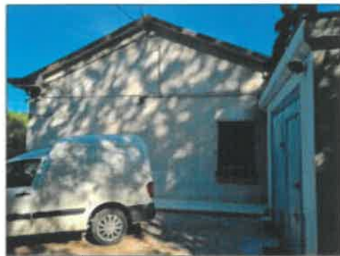
FOTO 09 - FRONTE LATERALE E VIST DELL'AUTORIMESSA
