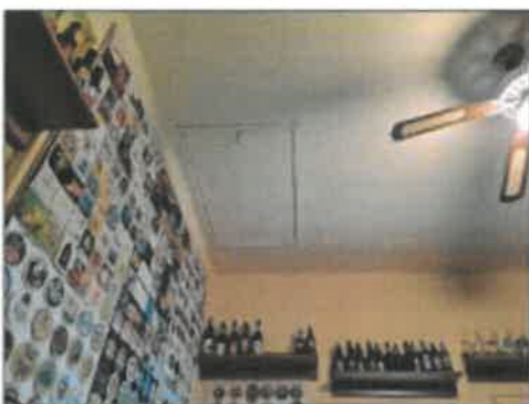
FOTO 44 - BOTOLA DI ACCESSO AL TETTO
