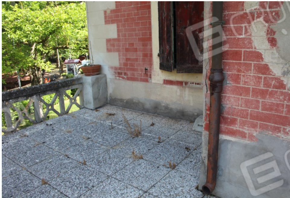
porzione di terrazzo piano primo
