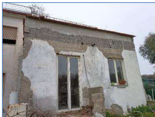
Fotografia 19 – Prospetto lato sud
