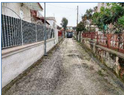
Fotografia 1 – Traversa via Rossano
