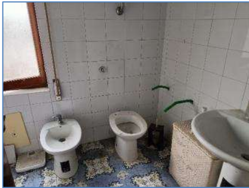
Fotografia 13 – WC piano primo
