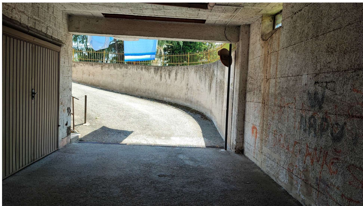
Rampa d'accesso ai box esterna al fabbricato
