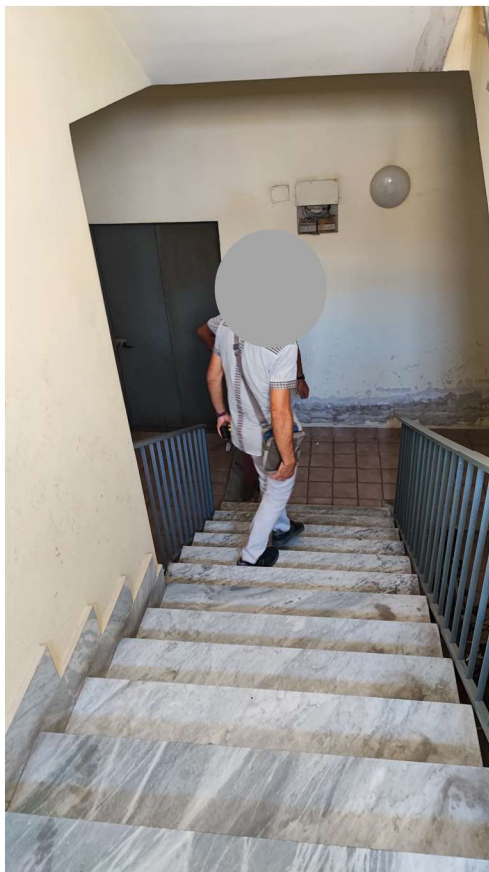
Rampa di scale d'accesso ai box interna al fabbricato
