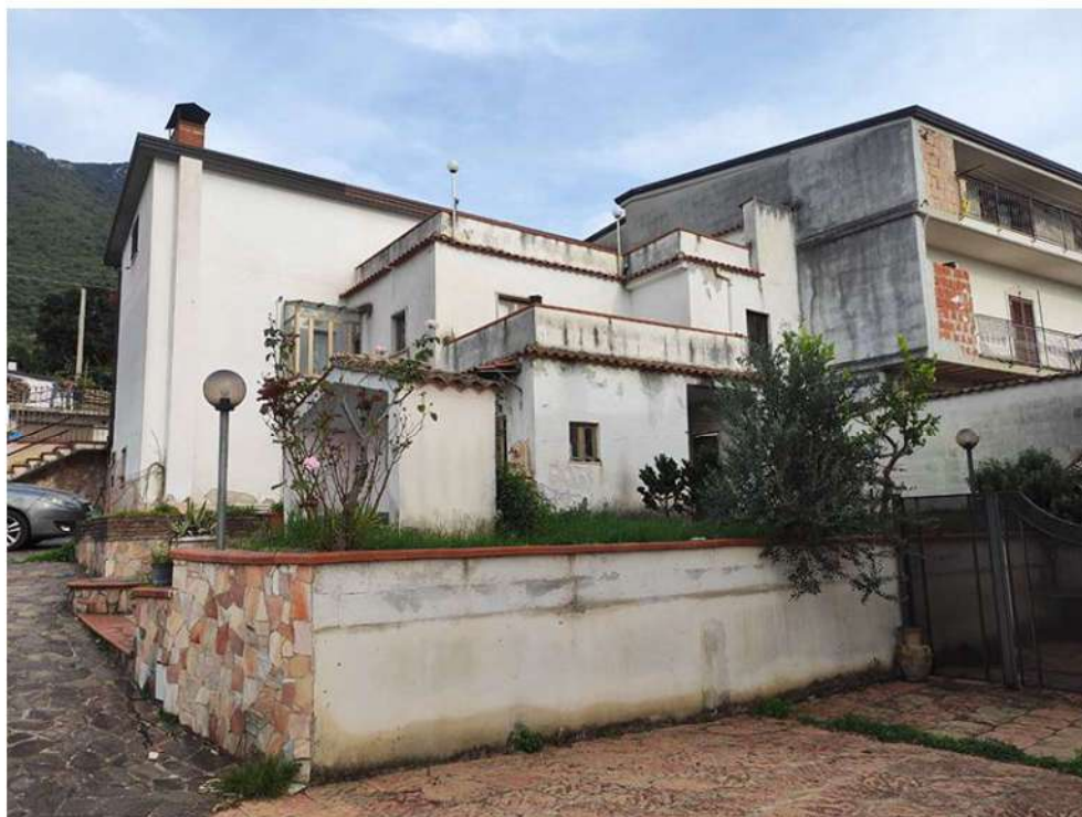
Vista dell'immobile da ovest (cortile interno)
