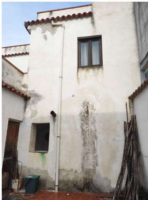
Vista dell'immobile da ovest (cortile interno)
