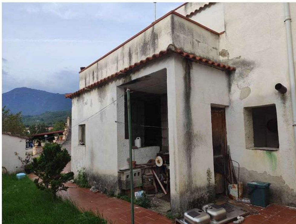
Vista dell'immobile da sud/ovest (cortile interno)
