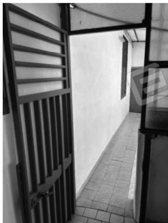
Foto n. 12 – Accesso al terrazzo dal ballatoio
