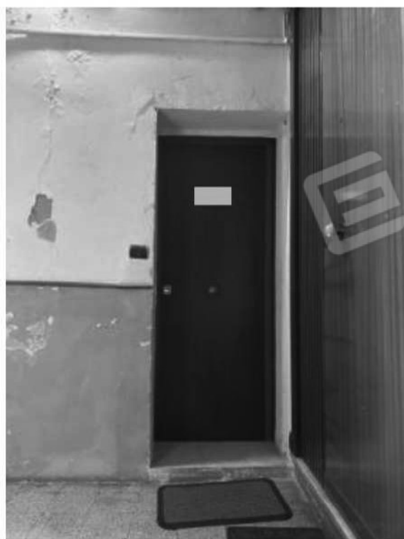
Foto n. 10 – Vano scala – accesso al ballatoio esterno
