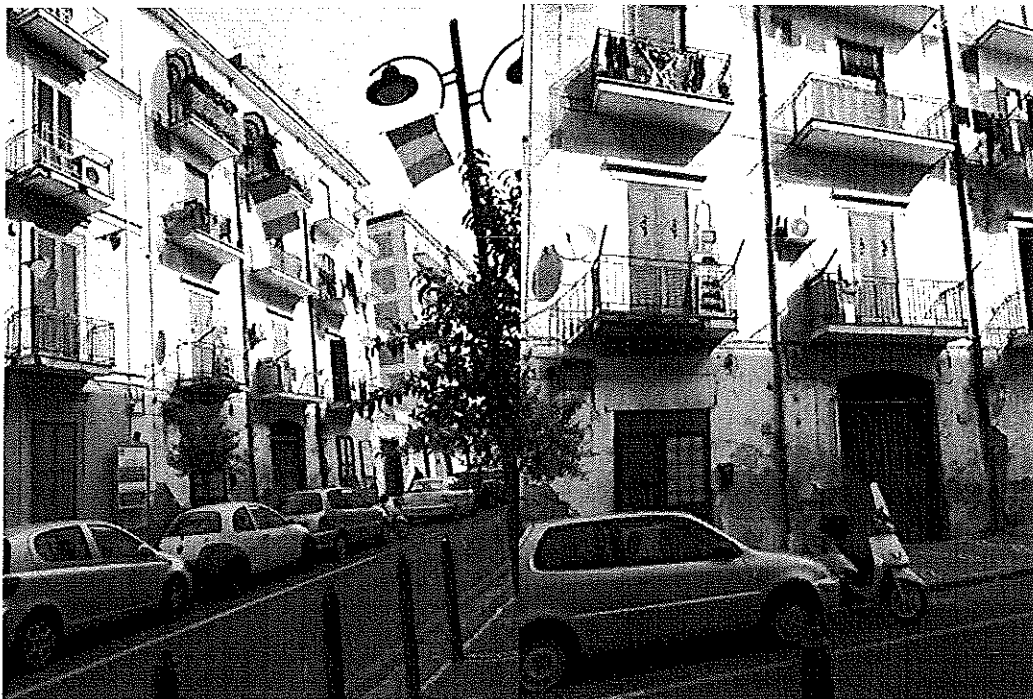
Foto I: Corso IV Novembre Foto II: particolare del fabbricato , il primo piano corrisponde agli affacci dell'appartamento su Corso IV Novembre
