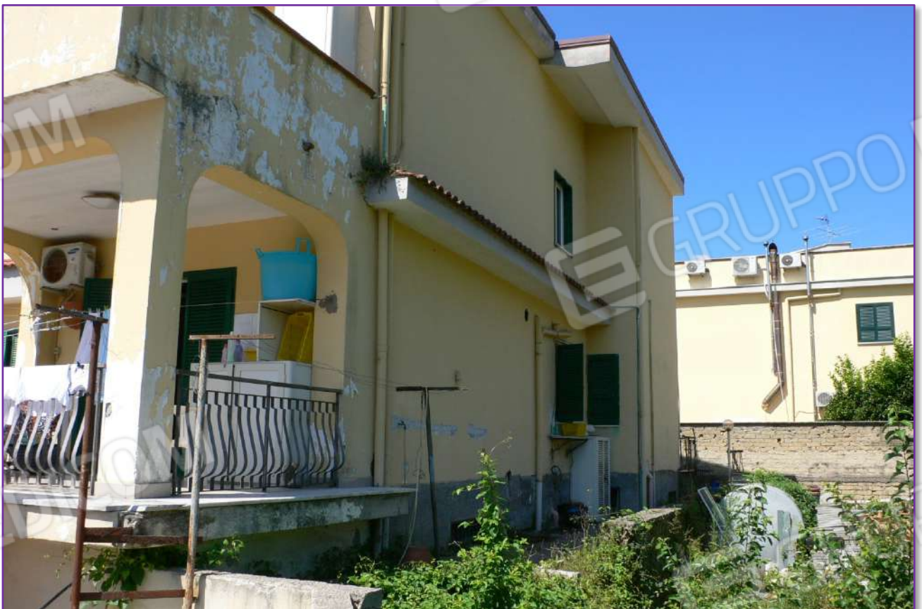
Foto n. 5 – Prospetto fabbricato lato nord
