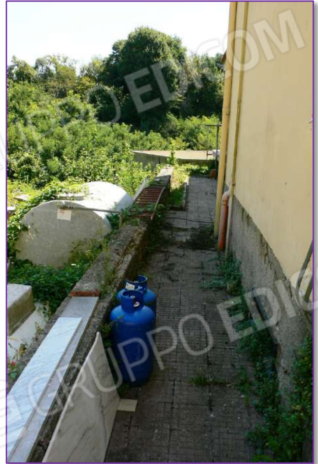
Foto n. 13 – Retro del fabbricato
