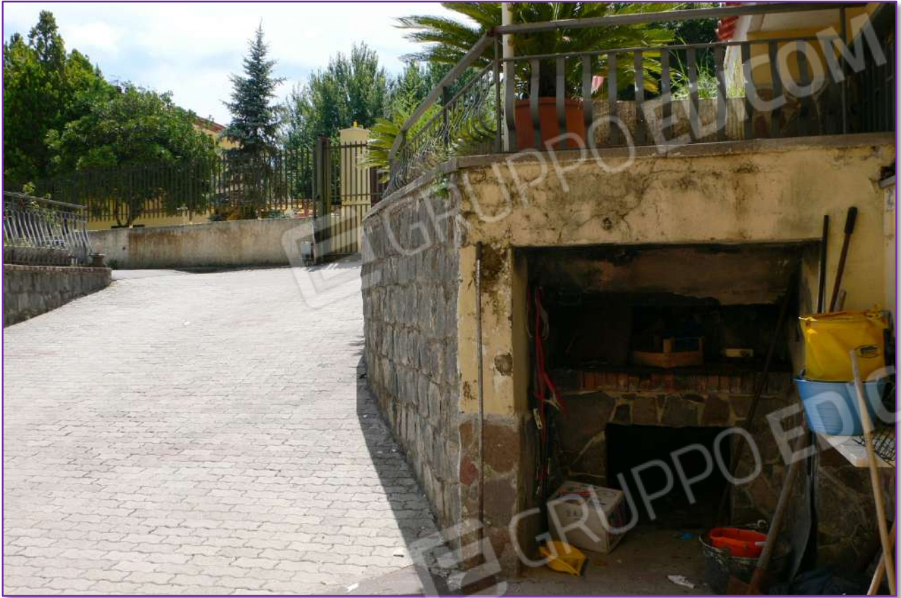
Foto n. 8 – Rampa (vista opposta)
