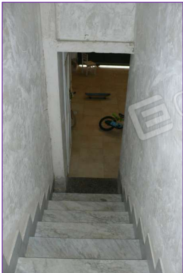
Foto n. 19 – Scala (seconda rampa)
