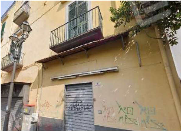
Foto 12 Ingresso Locale Commerciale
