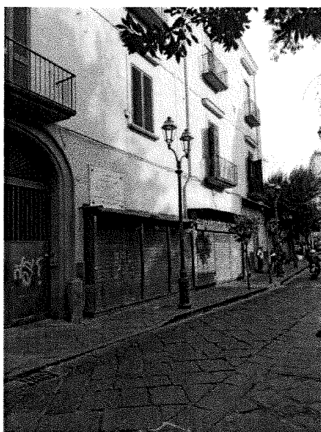
Foto 02 Facciata su strada
