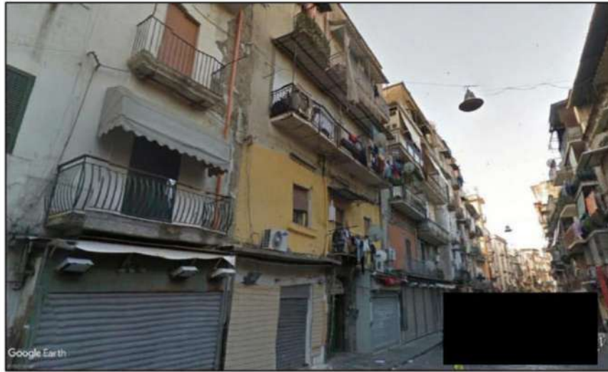
Figura n. 3 Il fabbricato di via Sant'Antonio Abate 116
