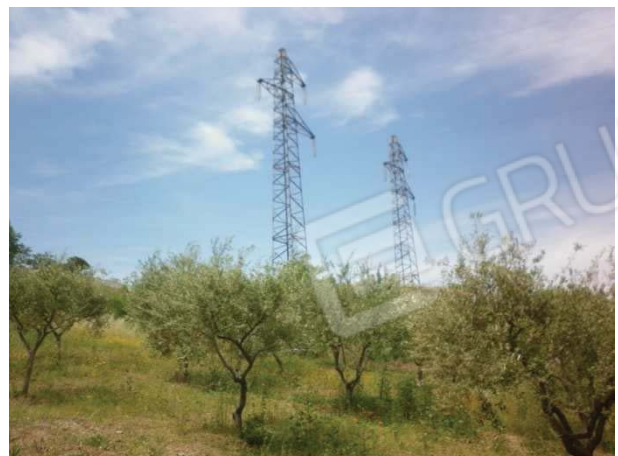
Foto 16 - P.Ila 40, tralicci elettrodotto
