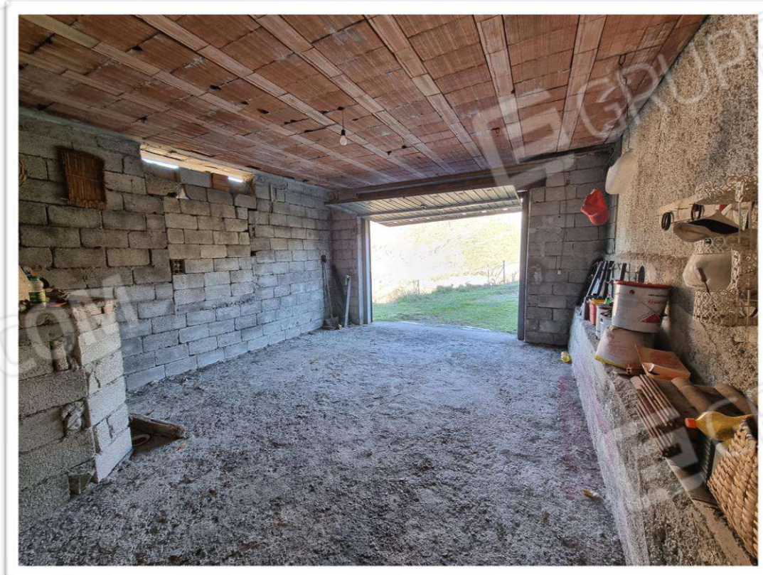
Foto 17 – Locale garage - piano 1°sottostrada
