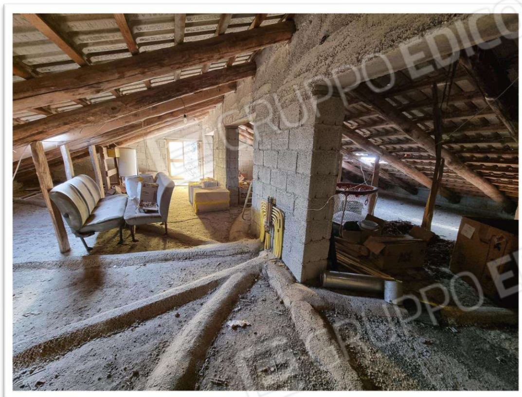
Foto 18 – Locale di sgombero - piano sottotetto
