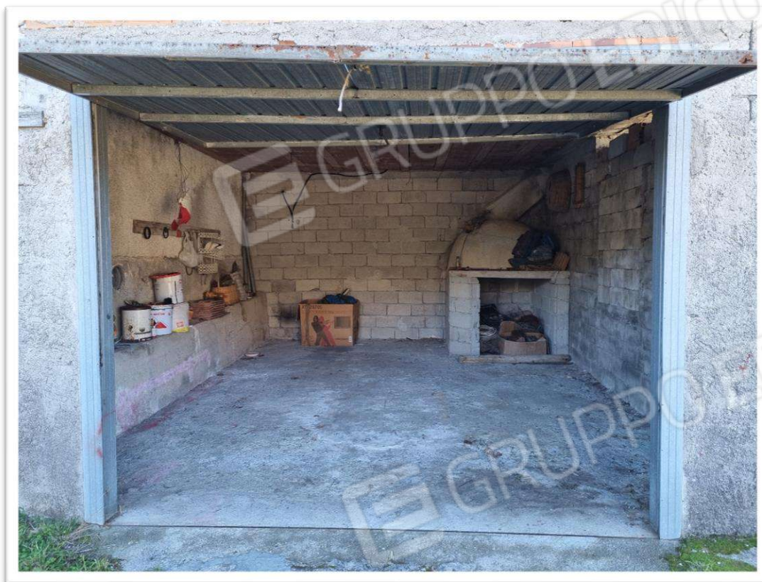
Foto 16 – Locale garage - piano 1°sottostrada
