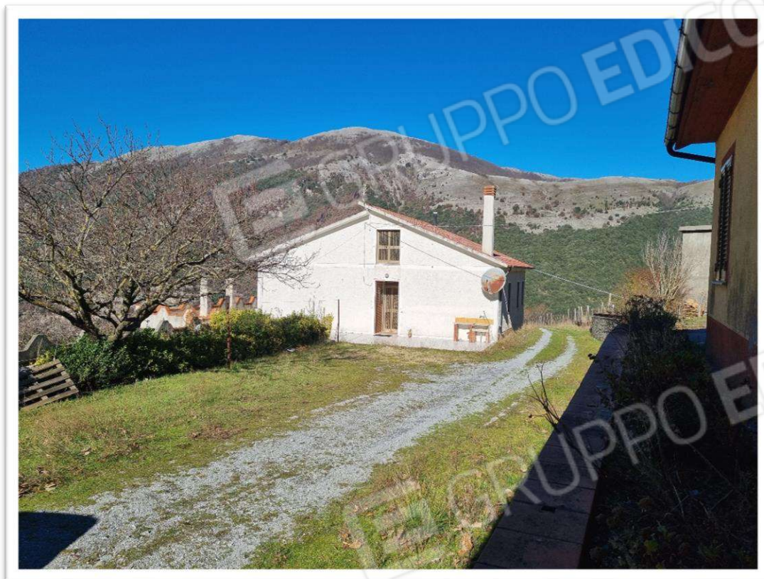
Foto 1 - Vista prospetto Sud
