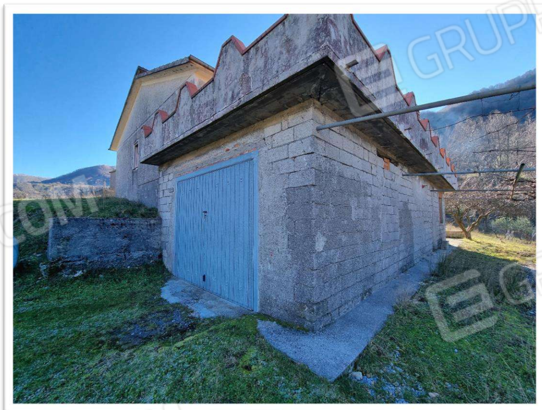
Foto 6 – Particolare vista Nord/Ovest
