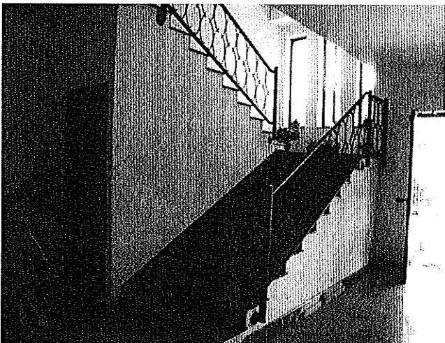
Vano scala del fabbricato
