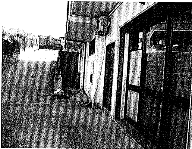
Rampa di accesso seminterrato e interrato – vista da ingresso seminterrato
