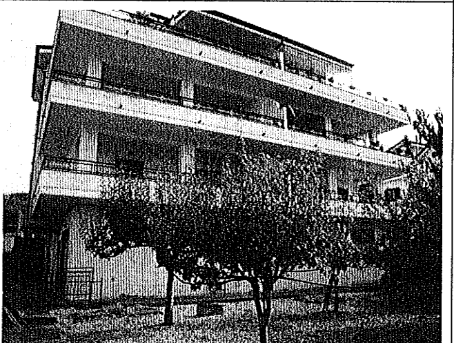
Esterno fabbricato lato sud-ovest
