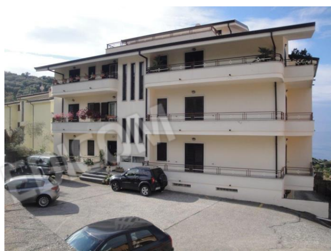
Esterno fabbricato lato nord-est
