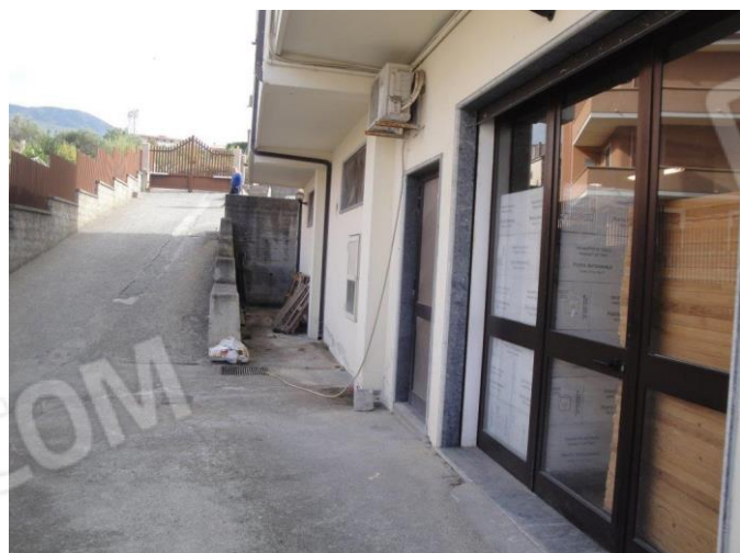
Rampa di accesso seminterrato e interrato – vista da ingresso seminterrato
