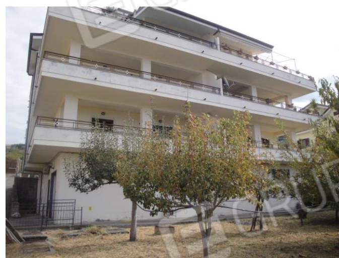
Esterno fabbricato lato sud-ovest
